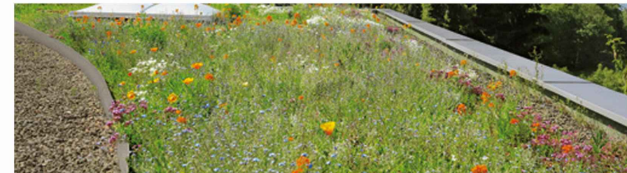
Toit plat végétalisé
