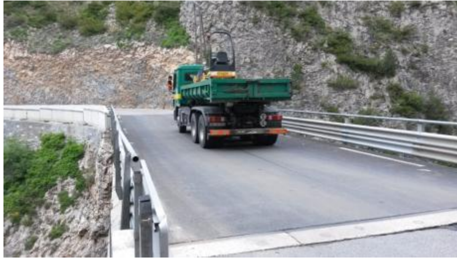
Photo 6 : Passage d'engin de l'entreprise COSI. Source : SEGIC INGENIERIE
