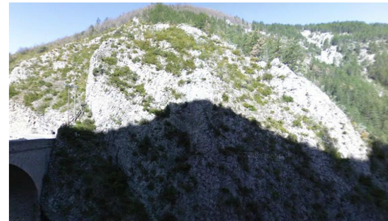
Photo 10 : Talus rocheux au Nord du Pont-Saint-Joseph, plus massif. Source : CETE Méditerranée
