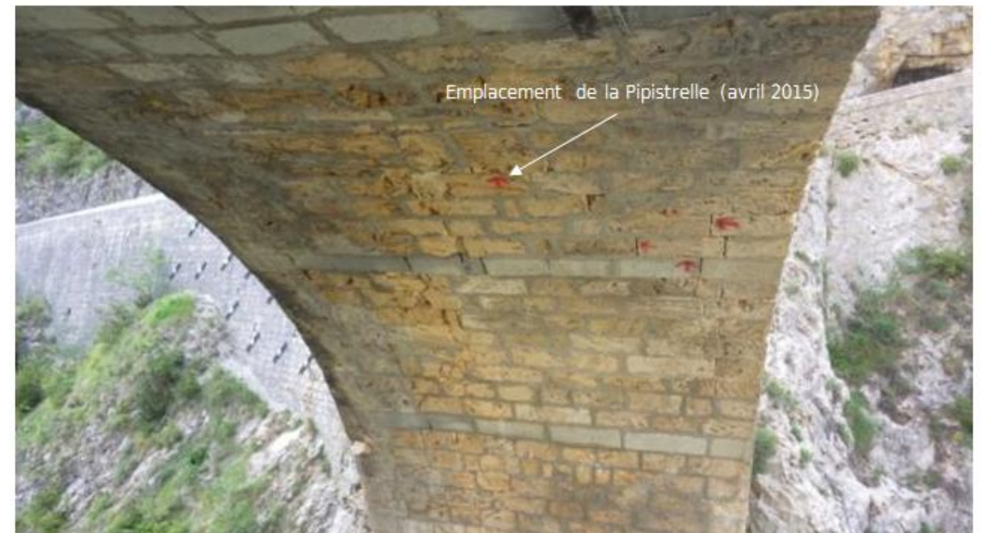
Photo 30 : Côté Est (Annot) – les flèches et points rouges sur le pont sont les interstices favorables pour héberger des chiroptères (©M. GAYAUD, GCP, Mai 2015)
