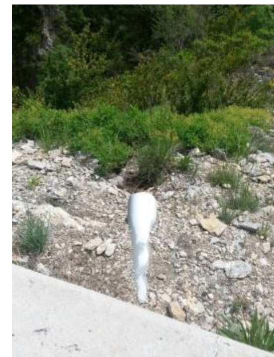
Photo 17 : Canalisation. Source : SEGIC INGENIERIE
