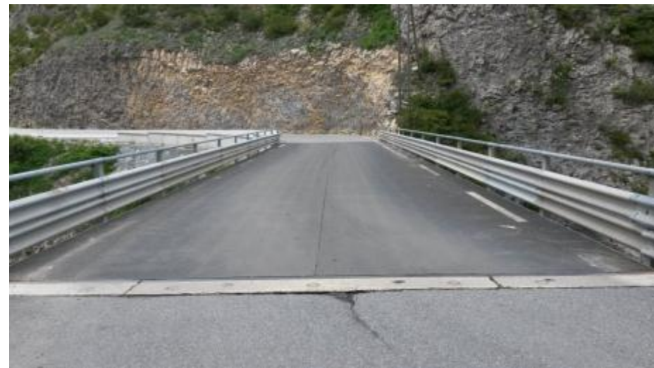
Photo 4 : Ouvrage de franchissement au niveau du Pont Saint-Joseph. Source : SEGIC INGENIERIE
