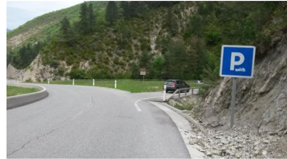
Photo 8 : Aire de stationnement aménagée en aval du pont. Source : SEGIC INGENIERIE
