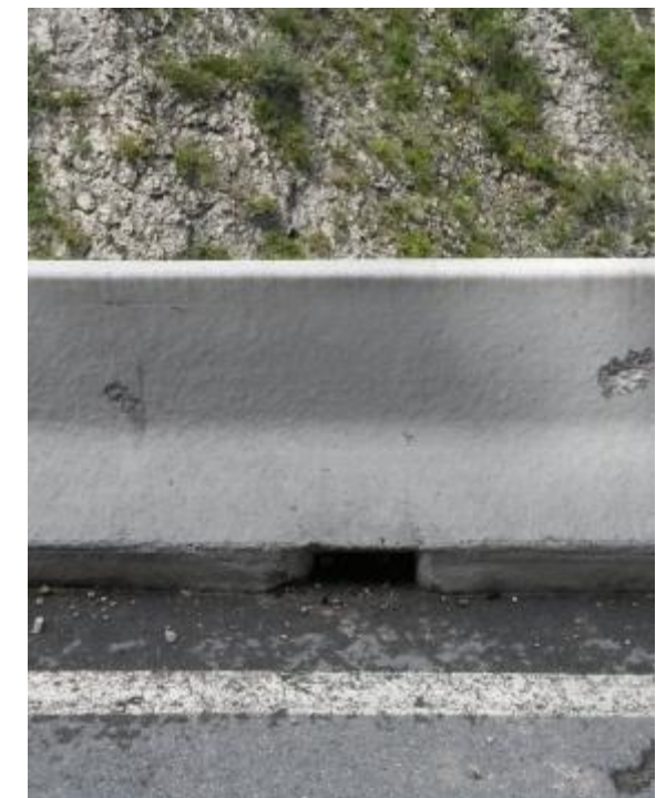
Photo 16 : Ouverture hydraulique le long de la RN 202. Source : SEGIC INGENIERIE
