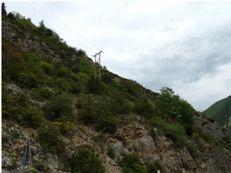
Photo 39 : Ligne électrique au niveau du pont Saint-Joseph. Source : SEGIC Ingénierie.
