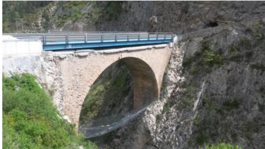
Photo 3 : Pont provisoire en aplomb de l'ancien pont. Source : SEGIC INGENIERIE
