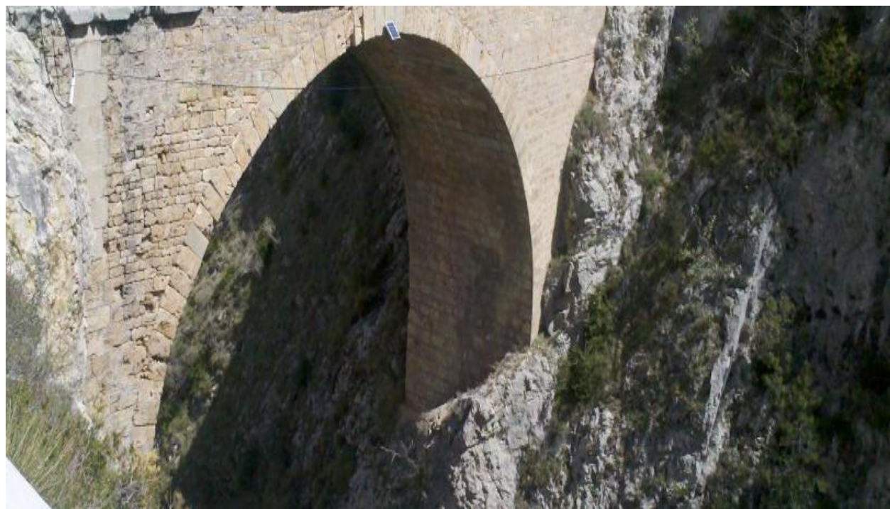
Photo 2 : Ancien Pont. Source : CETE Méditerranée.
