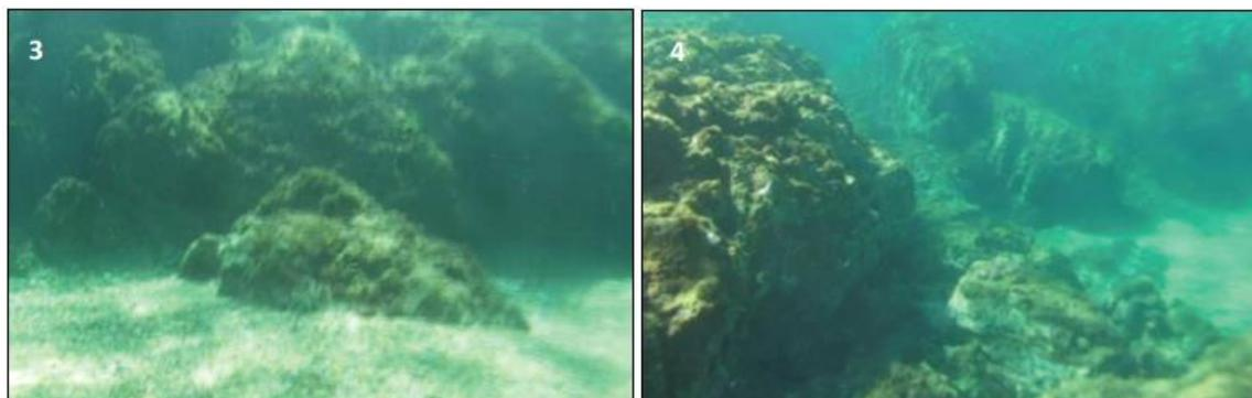
Photo 7 : extraits vidéos du pied de la digue Ouest – à gauche : bloc en partie ensouillé ; à droite : roche naturelle
