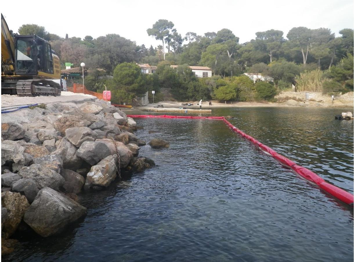
Figure 15 : Exemple de Filet anti-MES en bord de quai (source : Biotope)
