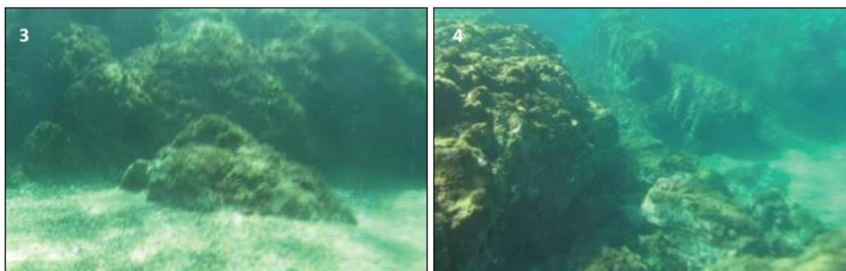
photo 18 : extraits vidéos du pied de la digue Ouest (réf. [8]) – 3 : bloc en partie ensouillé ; 4 : roche naturelle
