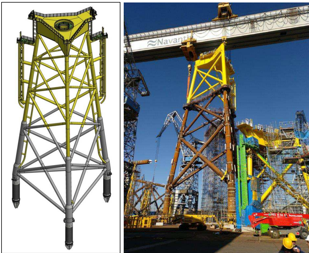
Figure 2 : Illustration d'une fondation jacket de section triangulaire (Ailes Marines)
