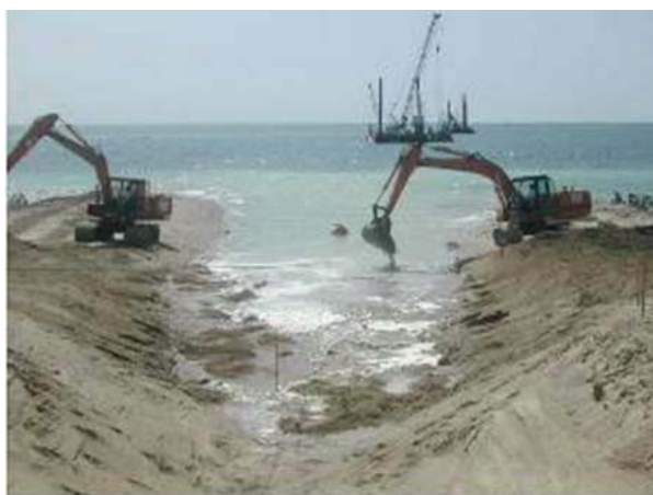
Figure 7 : Un exemple de travaux de tranchée à l'atterrage (Source : RTE)
