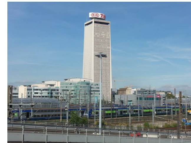
Voies ferrées et technicentre depuis la passerelle de la gare RER D Stade de France Saint-Denis (Source : MEDIATERRE Conseil)
