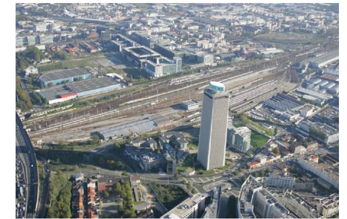
Abords de la Tour Pleyel depuis le boulevard Anatole France (Source : Etude d'impact ZAC Pleyel)
