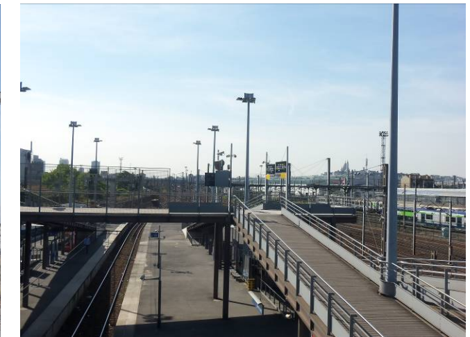
Gare RER D Stade de France Saint-Denis, vue vers le sud (Source : MEDIATERRE Conseil, 2016)
