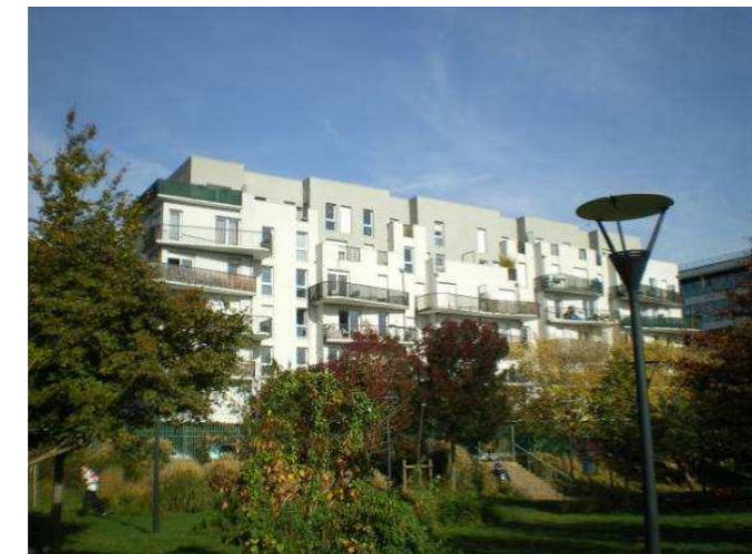
Immeubles depuis le square des acrobates (Source : ANTEA)
