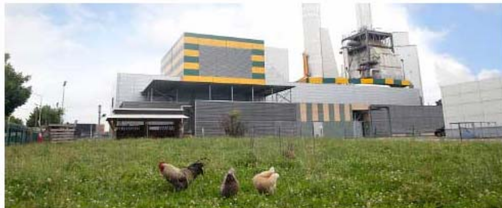
Centrale du fort de l'est (Source : Plaine Commune Energie)
