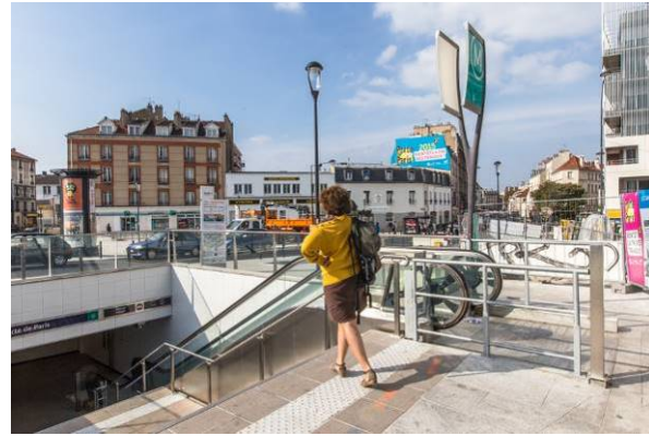
Nouvel accès à la station de métro Porte de Paris (Source : © P. Le Tulzo, Plaine Commune)
