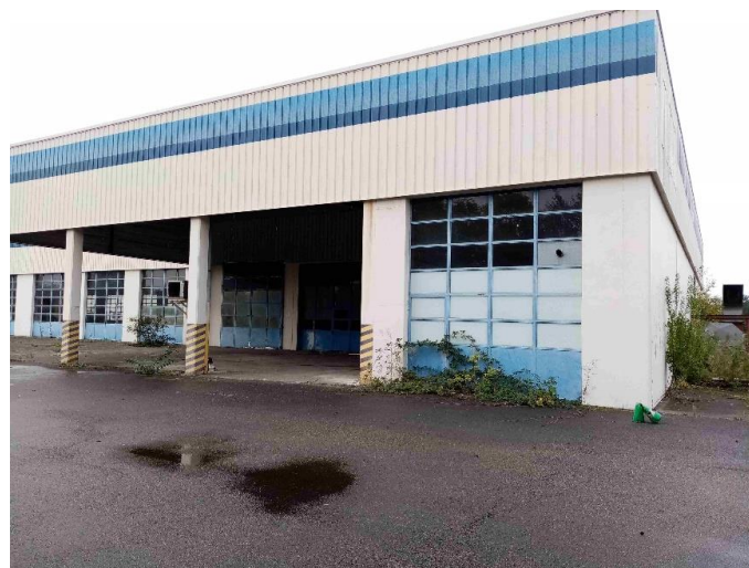
Illustration 11 : piliers bétons présentant un flux gamma de 120 à 150 c/s
