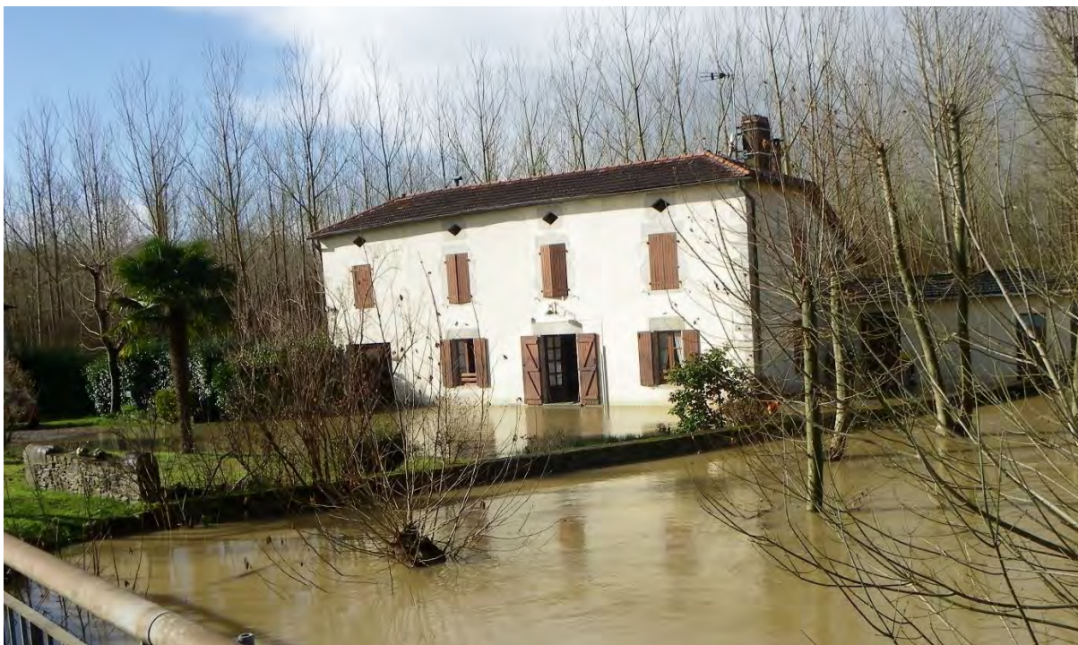
Photo 1 : Maison en bordure du Luy inondée en janvier 2014 sur la commune de Sagnac-et-Cambran (40) (source : Mairie de Sagnac-et-Cambran)
