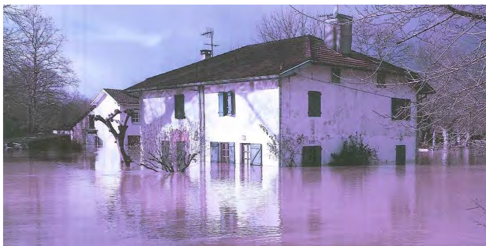
← Photo 1 : Inondation en janvier 2014 au lieu-dit « Vimport » de la commune de Tercis-les-Bains (40) (Source : Mairie de Tercis-les-Bains)
