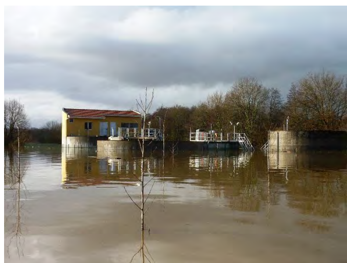
Photo 4 : Station de traitement des eaux usées isolée lors de crue de janvier 2014 sur la commune de Mées (40) (source : Mairie de Mées)
