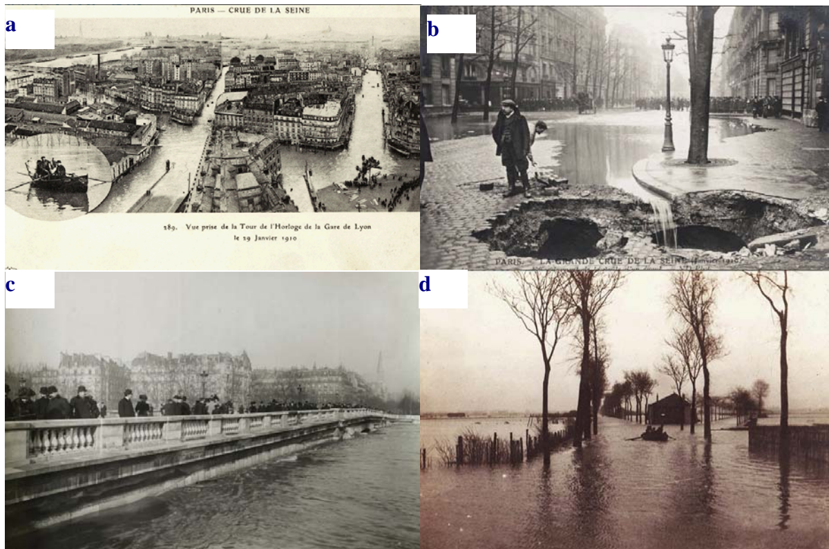
Figure 29 : Inondations de la Seine à Paris en janvier 1910 : a/ vue prise de la Tour de l'Horloge à la Gare de Lyon; b/ effondrement de la route d'un égout à Paris ; c/Pont de l'Alma à Paris ; d/ Gennevilliers, avenue du Pont de Saint-Denis
