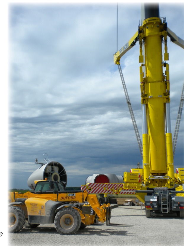
Source : DRIEE - chantier parc de Pussay (91)
