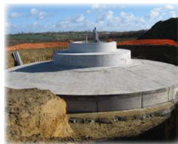
Source : Théolia chantier parc de Pussay (91)
