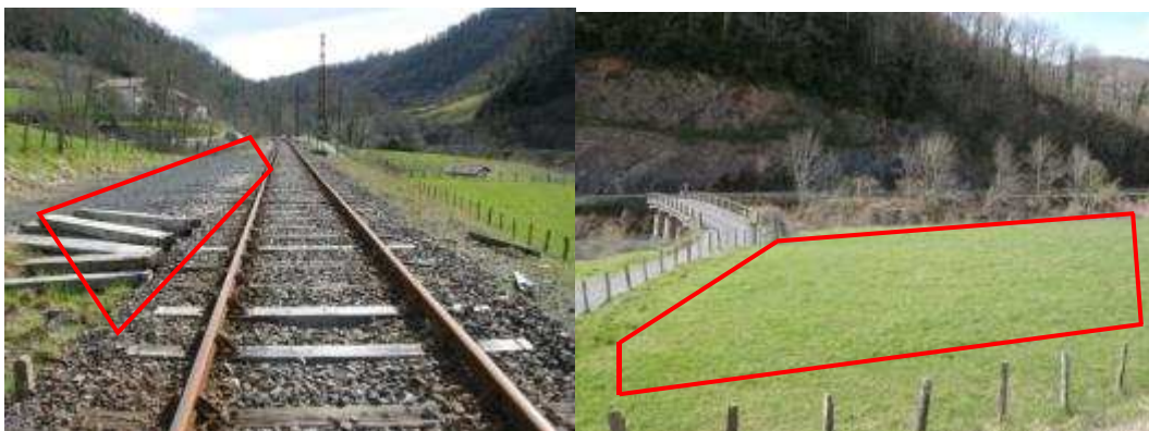
Figure 4 : aires de stockage en amont du PN 34 au PK 242+530
