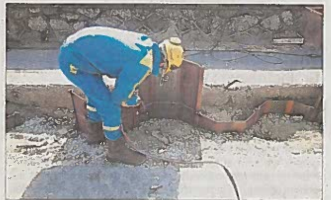
Les palplanches ont dû être coupées à certains endroits à cause du granite et des câbles de téléphone et de fibre optique ont été sectionnés.
