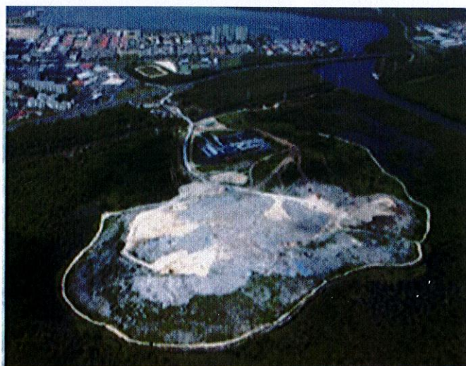
Etat de la décharge avant le début des travaux
