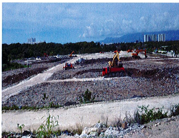
Avril 2011 : début des travaux d'excavation
