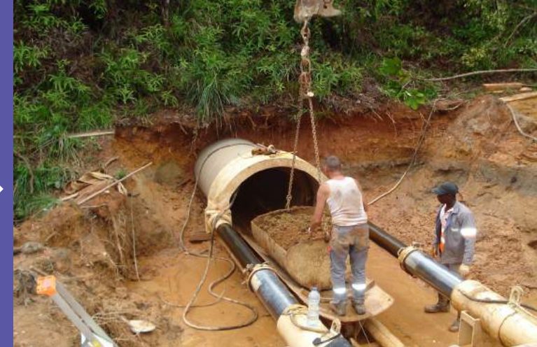
Ouvrage Hydraulique RN1 →
