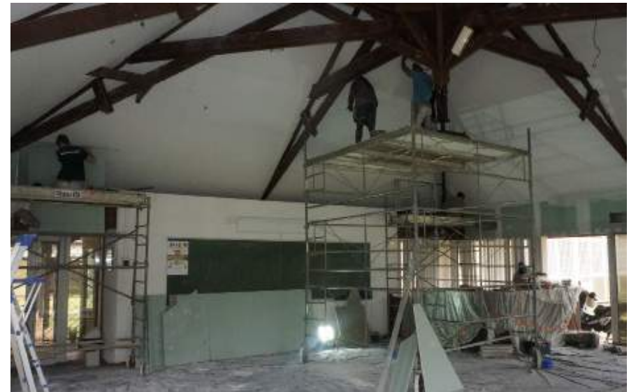
Travaux réalisés à la DEAL ( Vieux Port et Buzaré )
