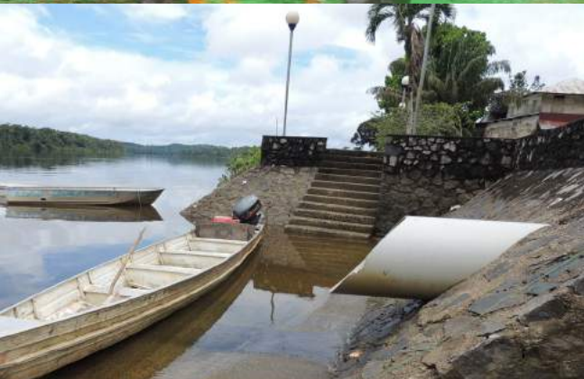
← 2 - Cale et escalier en béton au bourg de Régina
