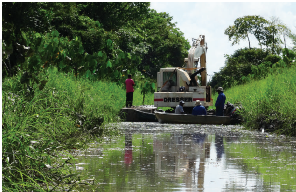
← Travaux de curage - Canal Roy .....
