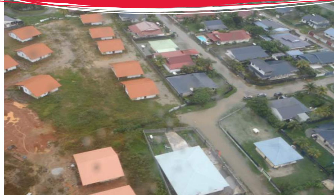
Inondation de la zone Maillard - Macouria ↑
