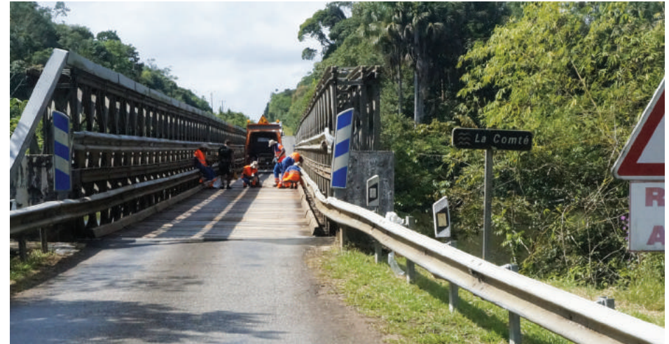
Travaux sur le pont de la Comté ↑
