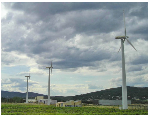
Exemple de parc éolien installé en zone d'activité, au bord de l'A7, à Donzère (26)
