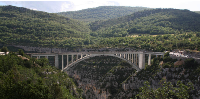
RD71- ouvrage de franchissement du canyon de l'Artuby
