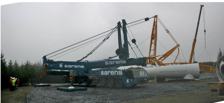
Exemple de plateforme et de grue. Chantier éolien du Haut Cabardès (11) 2007
