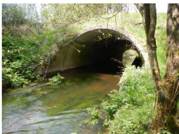
Photo OHn°2 vue de l'aval
