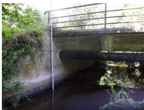
Photo OHN°1 vue de l'aval
