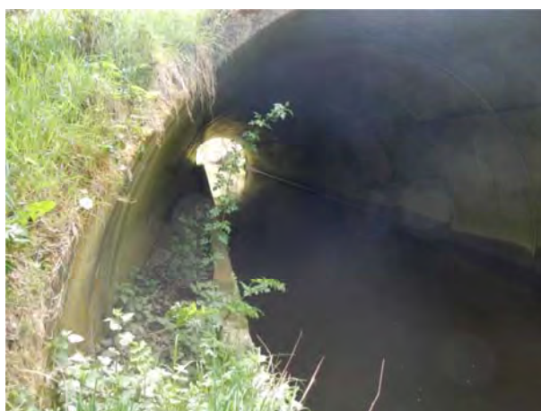
Photo OHn°2 vue de l'amont
