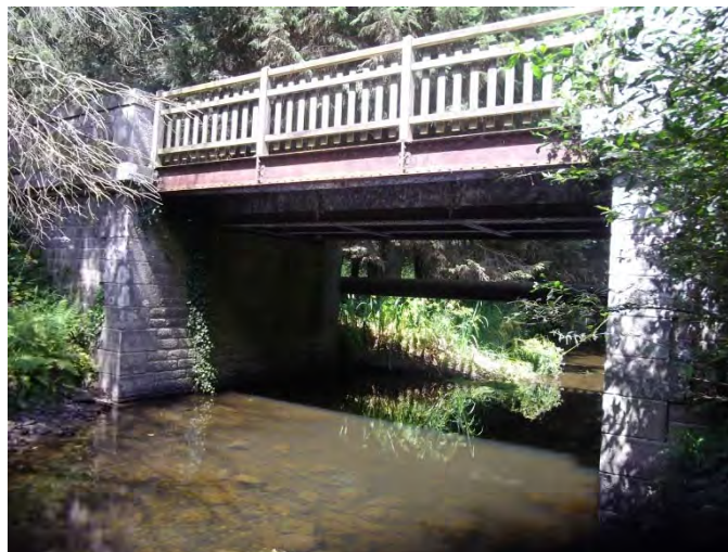
Photo OHn°3 vue de l'aval
