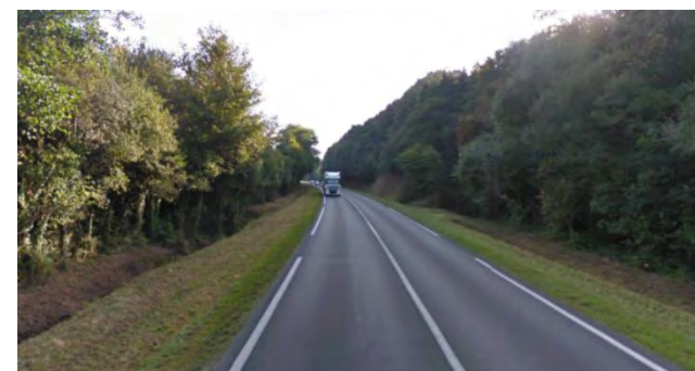
Largeur réduite et effet de paroi entre la RD23 et le giratoire RD790
