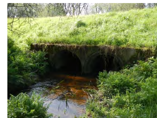
Les ouvrages sur la RN 164 actuelle : 2 Ø1000 mm (OH B)
