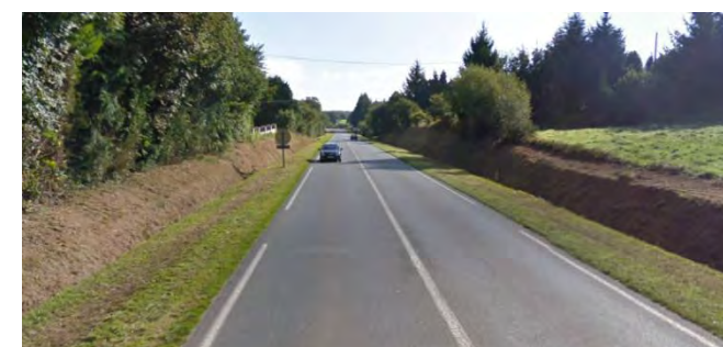
Section limitée à 70 km/h, alignement droit prédominant
