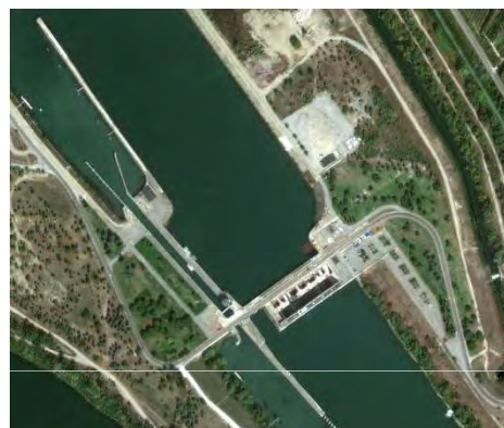
Usine et écluse Grand Gabarit
