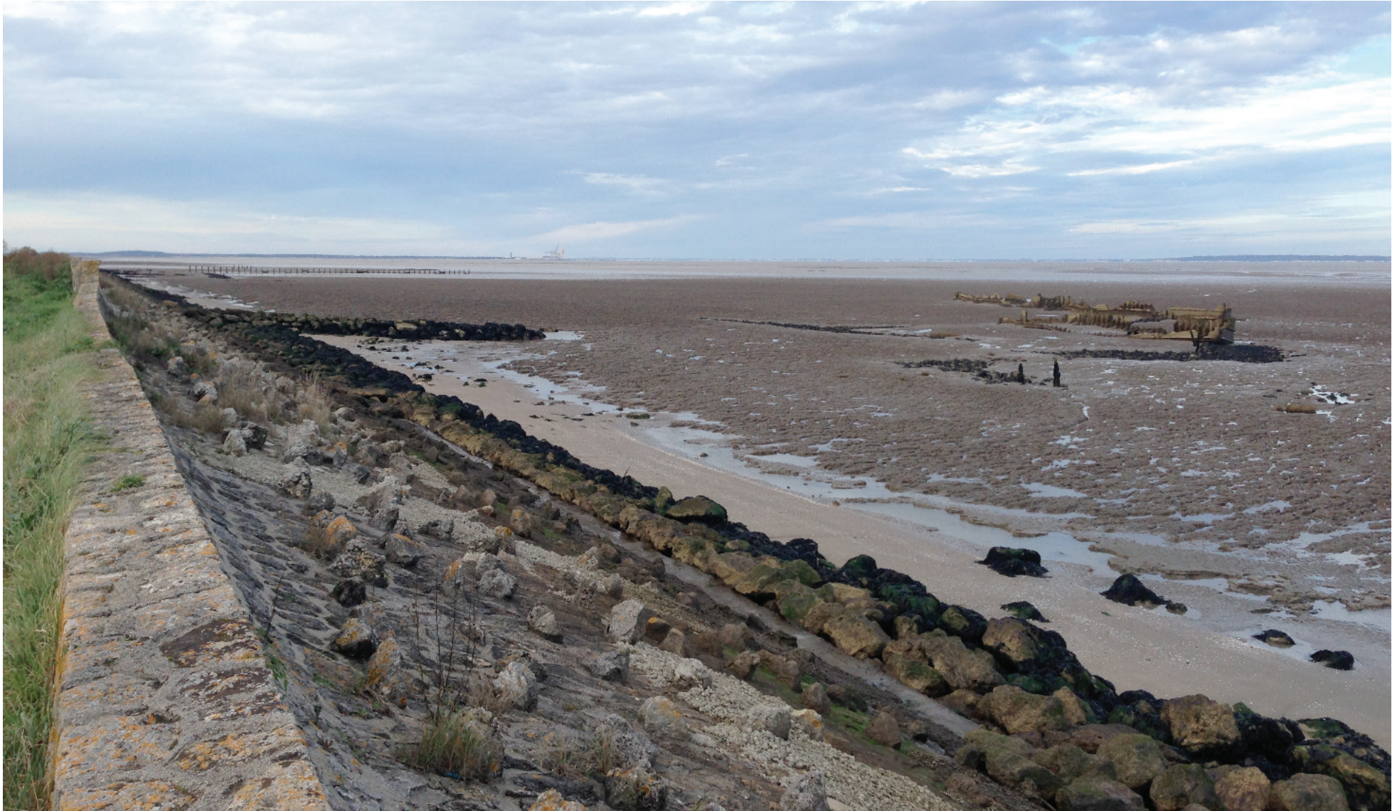
Digue du côté de l'estuaire, en direction du port de Talais
