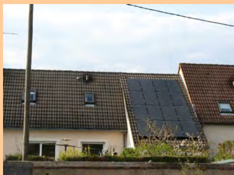
Fig. 155 : Panneaux solaires couvrant la quasi-totalité d'un pan de toiture d'un garage (Photographie DREAL Centre, 2010).
