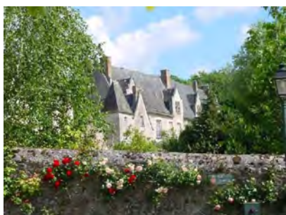
Fig. 119 : Détails architecturaux qui ornent l'architecture. (Photographie DIREN Centre 2008)
