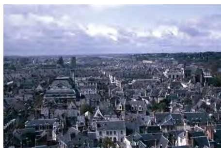
Fig. 120 : Les toits de Tours : de l'ardoise à perte de vue (Photographie L.M. Coyaud, 1962)
