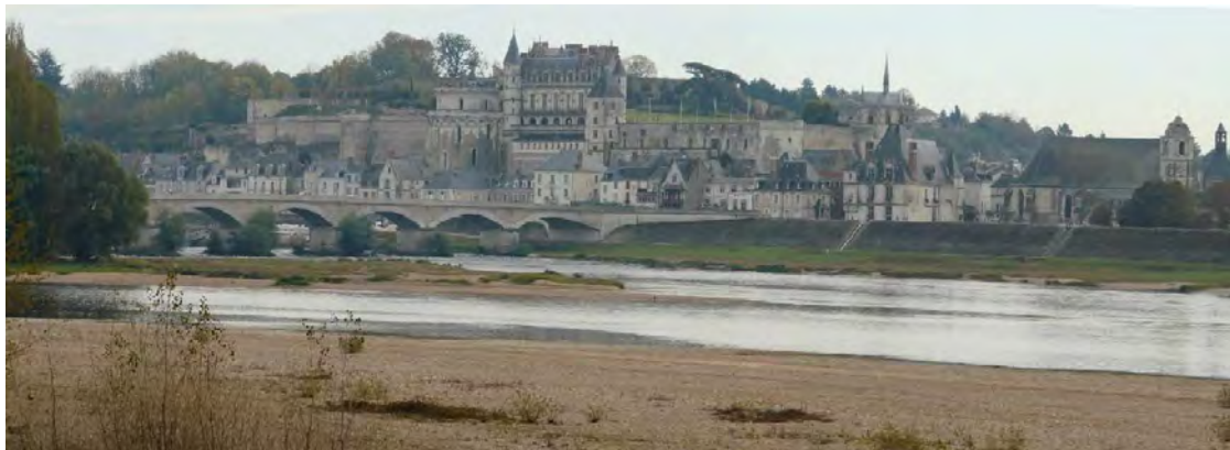
Fig. 4 : Amboise offre une image emblématique de la ville des bords de Loire avec son château dominant un front bâti. (Photographie Diren centre 2008)
