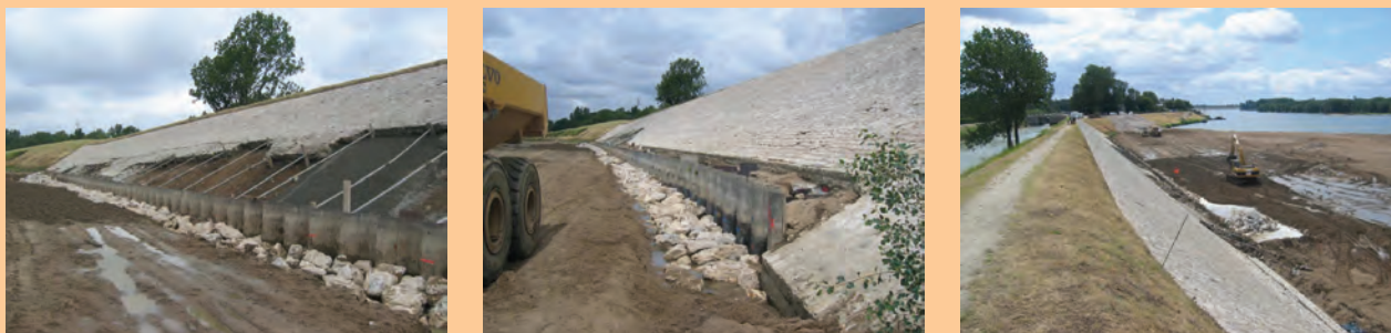
Fig. 202 : Travaux de confortement de la digue à Combleux, Loiret : Mise en place d'enrochements dissimulant les palplanches et reconstruction du perré dégradé. (Photographies Diren Centre, 2004)
