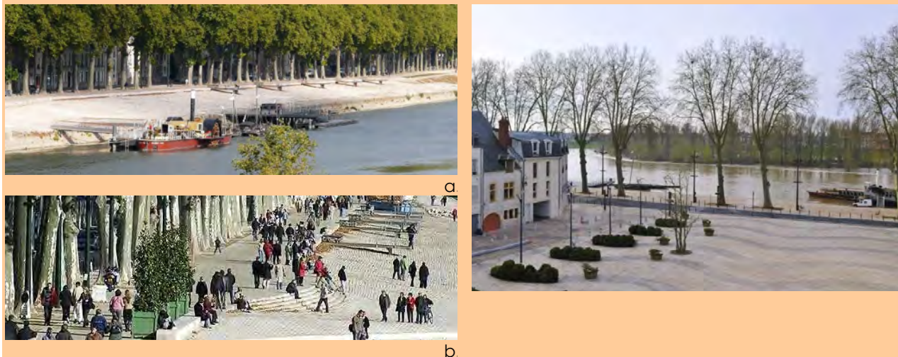
Fig. 46 : Réaménagement contemporain des quais et réouverture sur le fleuve. (Photographies Diren Centre, a et c et Ville d'Orléans, b)
