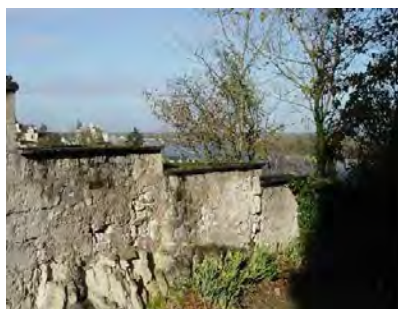
Fig. 118 : Tuffeau, pierre de taille et enduit à la chaux pour réaliser ce muret. (Photographie DIREN Centre 2008)
