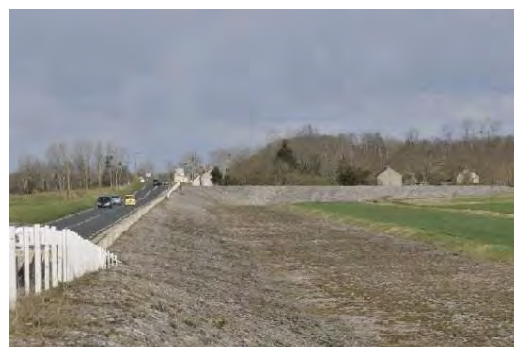
Fig. 15 : Digue et déversoir. (Photographies DIREN Centre 2008)
