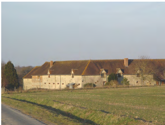
Fig. 73 : Corps de bâtiments de ferme de grande qualité architecturale (Photographie Diren Centre, 2009)
