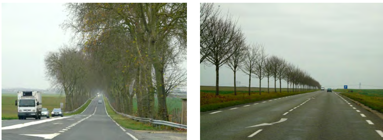
Fig. 165 : Suppression partielle et non remplacement d'un tronçon d'alignement (à gauche) ; reconstitution partielle d'un seul côté de la chaussée (à droite) (Photographies Diren Centre, 2005)
