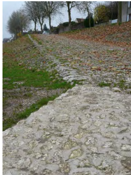
Fig. 40 : Rejointoiement en béton sur le tablier pavé du quai. (Photographies Diren Centre, 2008)
