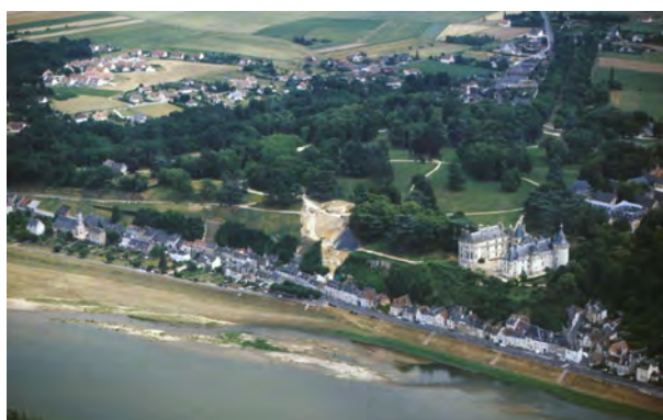
Fig. 78 : Eclatement et étalement urbain, en rupture avec l'alignement des fronts bâtis en bord de Loire. (Typologie paysagère de la vallée de la Loire – A. Mazas, Diren Centre, 1999)
