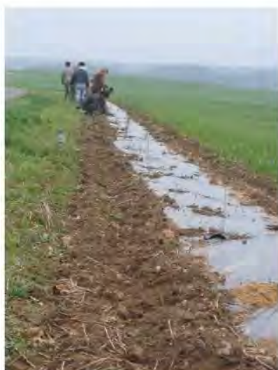
Chantier de plantation à Abilly
