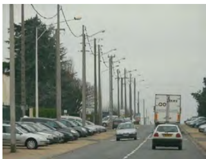
Fig. 146 : Multiplication des réseaux le long d'un axe routier majeur : banalisation de l'approche et dégradation du site. (Photographie Diren Centre 2009)
