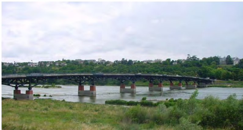
Fig. 135 : Une structure fine, une silhouette discrète. Un choix architectural qui s'insère remarquablement avec l'horizontalité du fleuve. (Photographie Diren Centre 2006)
