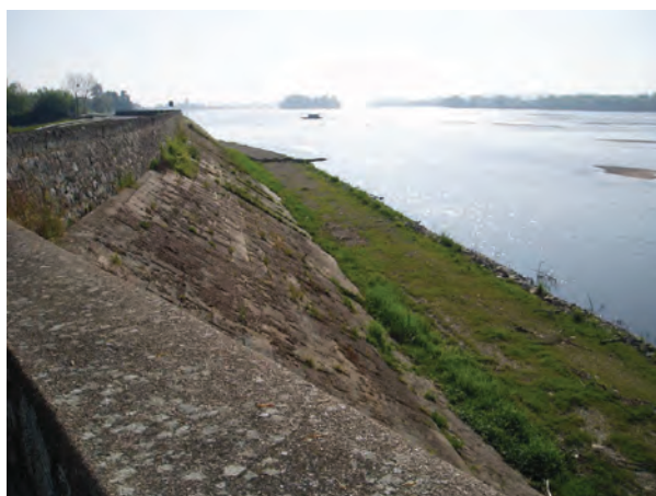
Fig. 198 : Talus avec perré et mur parapet en sommet de levée, perré à flanc de digue et rampe d'accès. (Photographies Diren Centre, 2008 )
