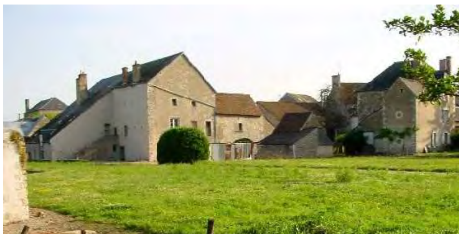
Fig. 26 : Exemple de bâti conditionné par les crues : escalier extérieur et étages permettant de s'échapper (photographie DIREN Centre)
