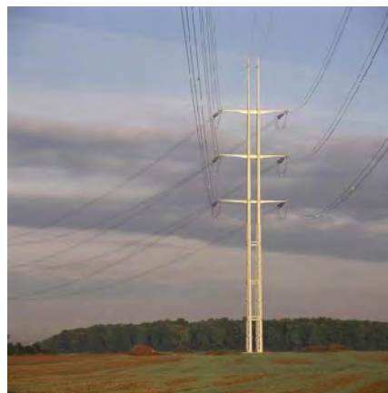
Fig. 147 : Exemples de supports dits architecturés : pylônes type « Muguet » et « Roseau » sur ligne 400 000 V. (Photographies Réseau de Transport d'Electricité)
