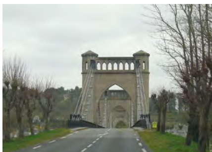
Fig. 131 : L'habillage des piles surcharge considérablement l'ouvrage et crée un effet pastiche particulièrement dommageable (Photographie Diren Centre 2009).
