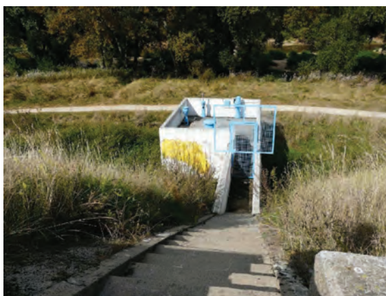
Fig. 201 : Local technique en pied de digue. L'escalier est entièrement refait en béton. (Photographies Diren Centre, 2008)
