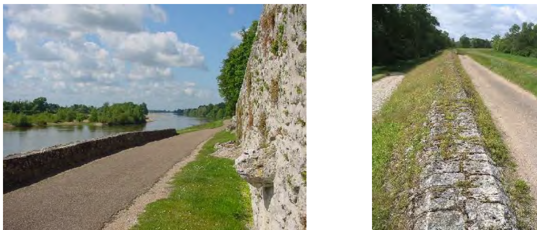
Fig. 13 : Deux exemples de levées sur les bords de la Loire. (Photographies DIREN Centre)
