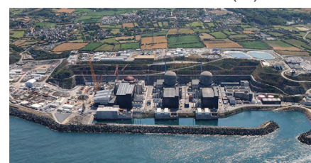
Centrale nucléaire de Flamanville (50)
