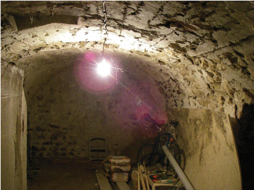
**Figure n°19 :** Exemple d'une cave avenue Gabriel Péri – maçonnerie constituée essentiellement de moellons de gypse
