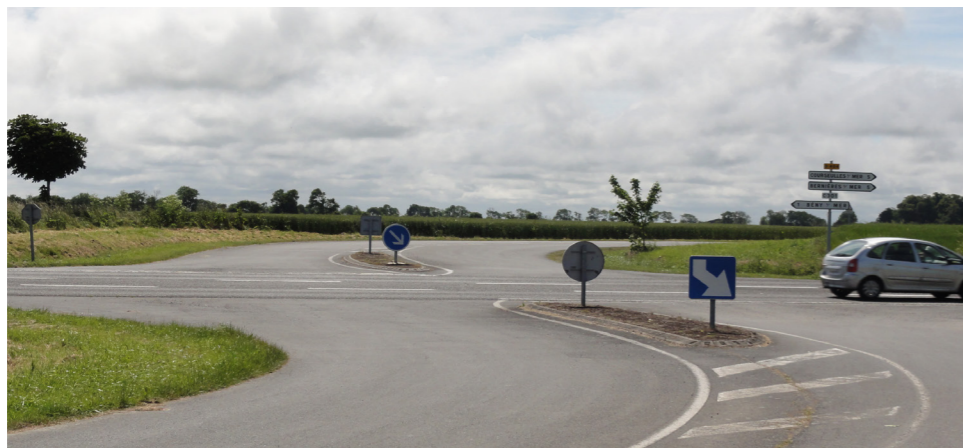
Carrefour RD 404 / chemin des Moulineaux
