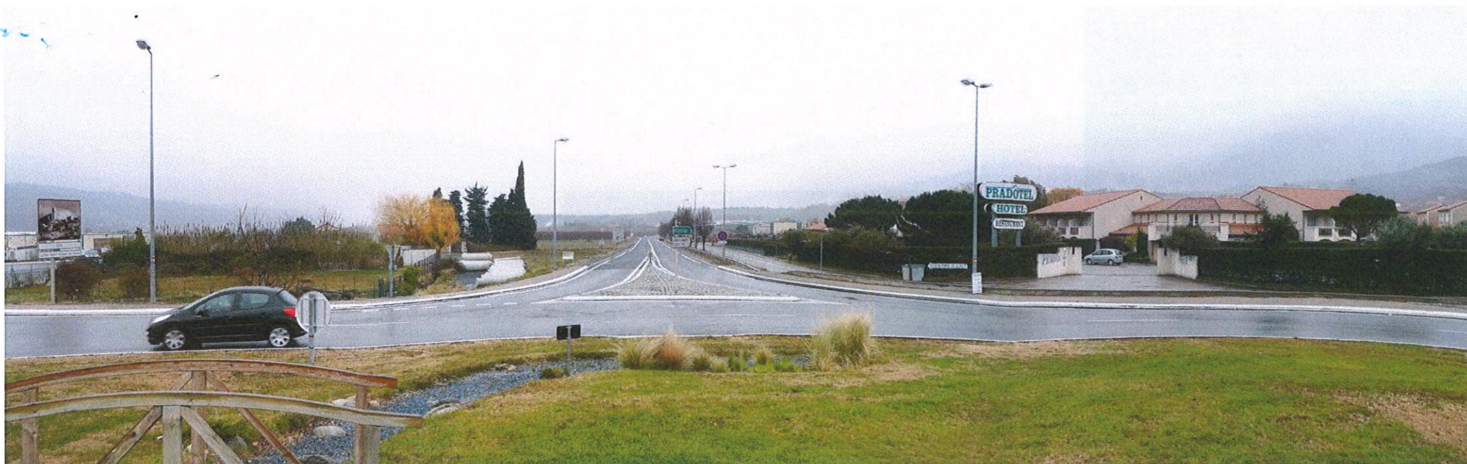
Branche Est du giratoire (RN116) depuis le giratoire
