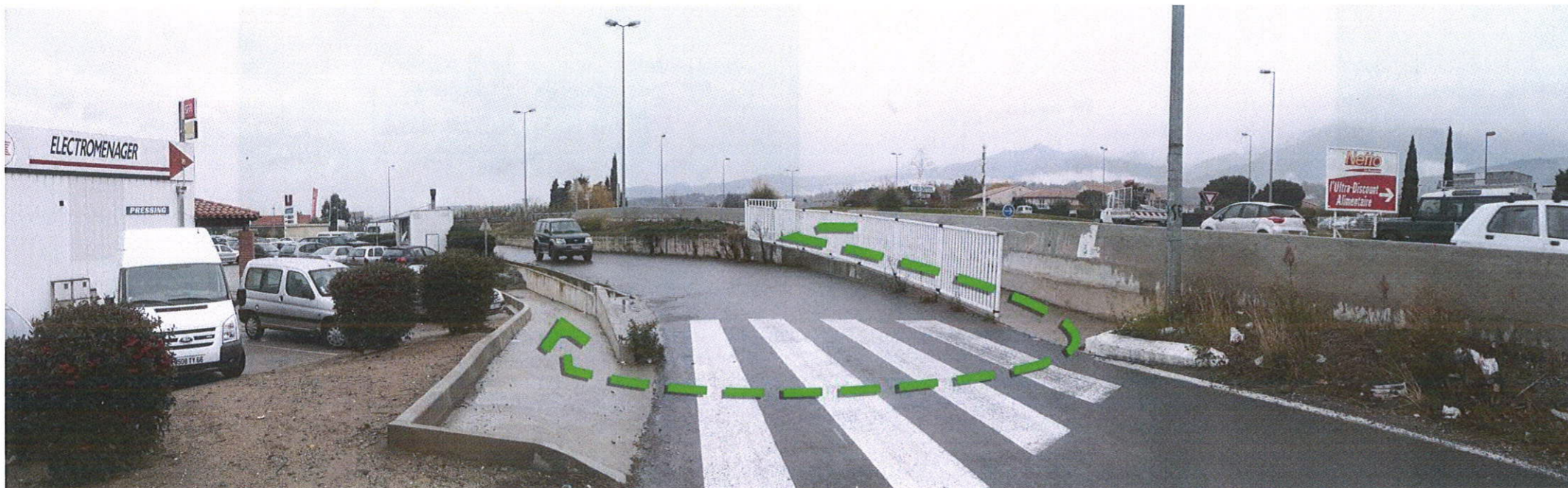
Traversées piétonnes « aériennes » existantes sur RN116 entre « Netto » et zone commerciale « Gibraltar »
