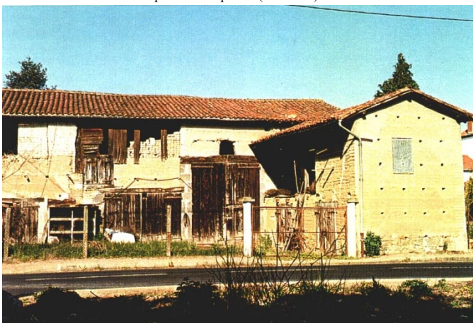
PONT ASTIER : corps de ferme, spécificité des matériaux : pisé et bois.
