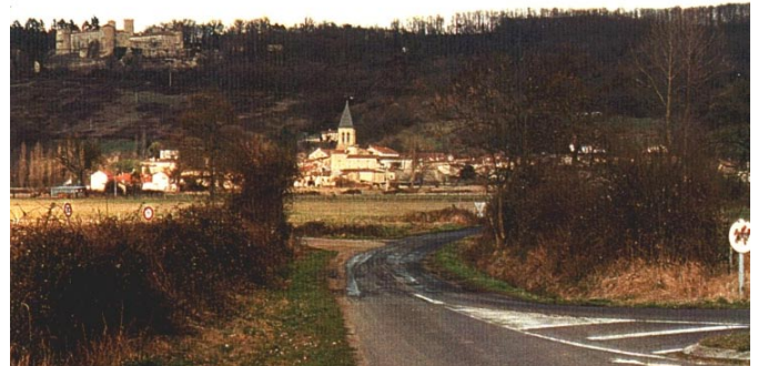
Ravel : le village et le château qui domine tout le secteur.
