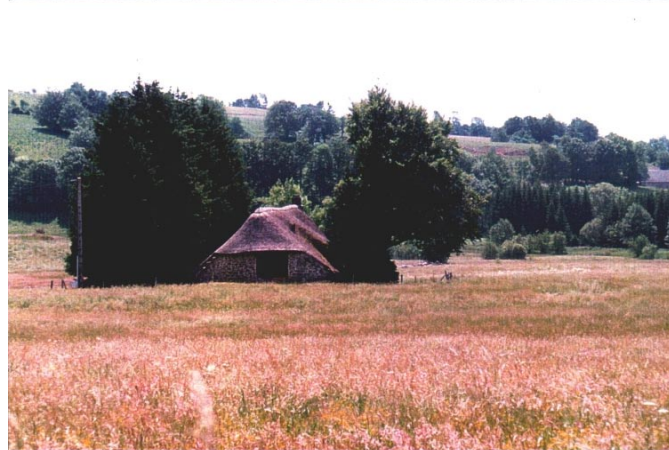
Picherande : maison restaurée, toiture en chaume
