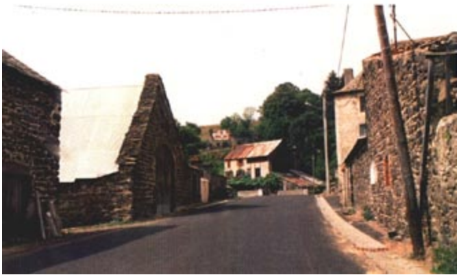
Entrée de Dauzat : La rigueur du bâti contraste avec la qualité du site. Les toits de Dauzat que l'on découvre depuis l'église. Une reconversion s'est opérée de la chaume ou de la lauze vers la tôle, la tuile et l'ardoise dans la plus grande hétérogénéité des couleurs. Point de vue depuis le RD32 : Un des points de vue majeur à laisser dégagé.
