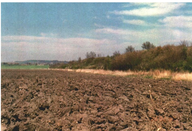
La voie ferrée sur talus, souvent occupé par des broussailles est une des rares coupures dans ces paysages de plaine.
