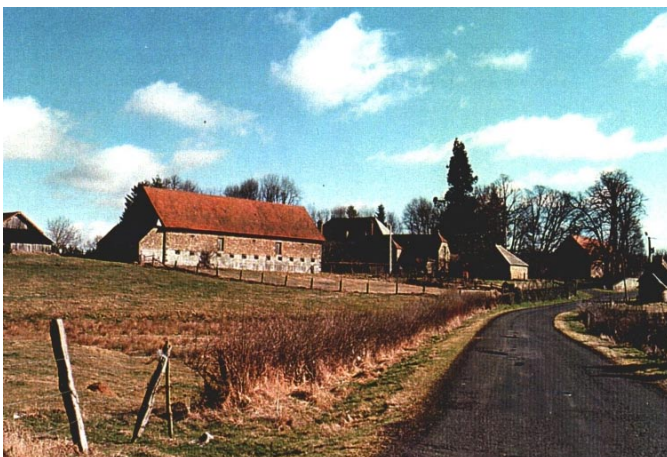
Domaine de Boisset : hétérogénéité des toitures et éclatement des bâtiments, accompagnement végétal très fort.
