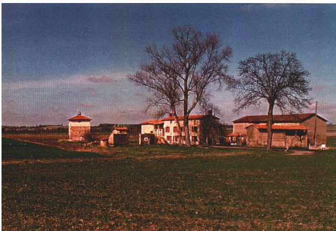
Ferme de Chez Barriots : exemple d'un ensemble complet offrant une architecture très typique de ce secteur.
