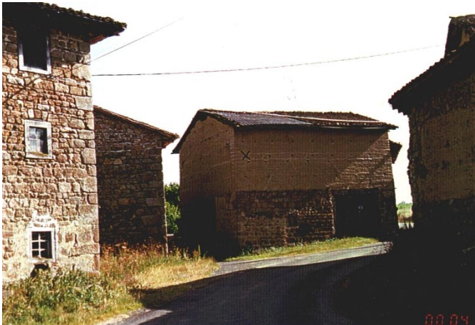
Maisons en pierre et pisé, village au dessus de la plaine (Paillargues - Marsac en Livradois)
