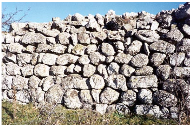
mur de basalte
