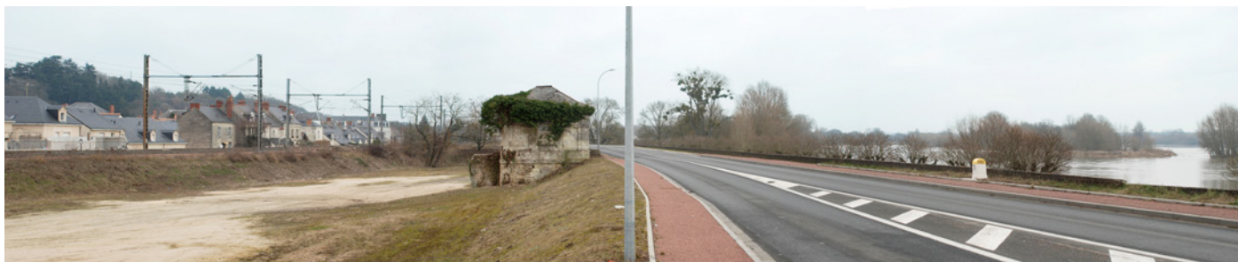
6. Espaces délaissés entre la route sur la levée et la voie de chemin de fer
