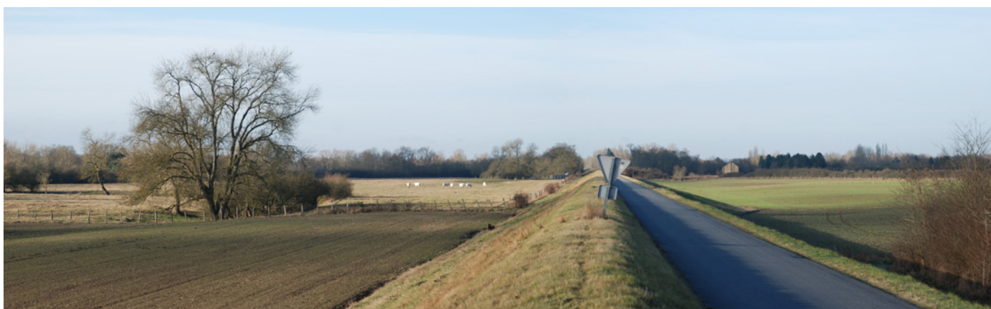
5 . Route en levée traversant l'espace agricole de la plaine
