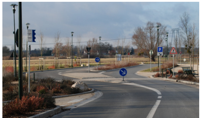
5. Un aménagement trop technique et disproportionné en sortie de village.
