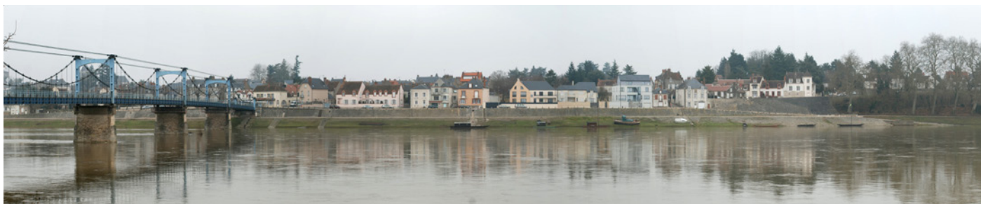
1 . De part et d'autre du pont s'étend le front de Loire du port de Châteauneuf, surelevé par les quais maçonnés et prolongé par la promenade du Chastaing à l'est.
