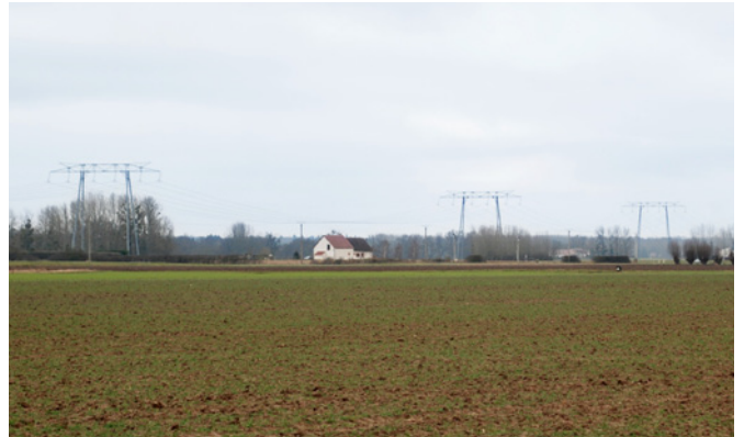
5 . La ligne à haute tension rompt l'harmonie de la vallée en imposant une échelle monumentale dans un paysage tout en sensibilité.
