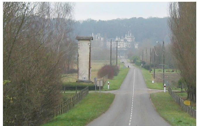
2. Poste électrique dans la perspective du château
