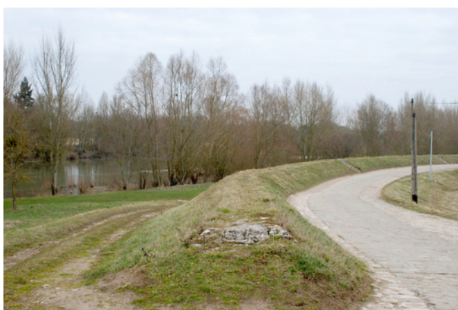
2. Le Cher, une rivière intime aux abords ouvrages
