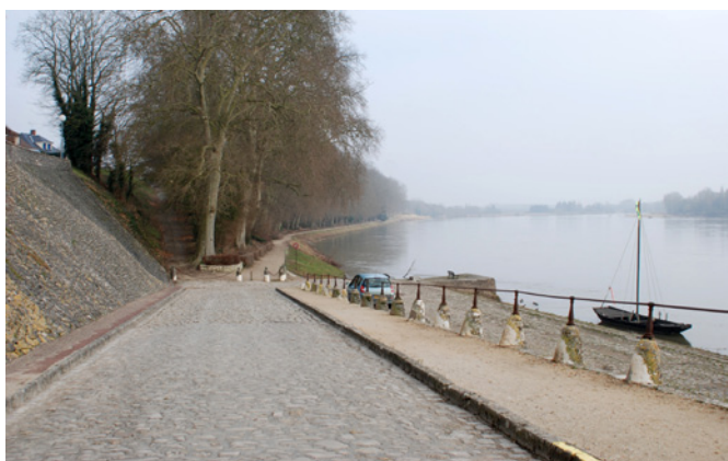
3 . Le départ de la promenade du Chastaing : les quais se terminent en douceur sur une double cale permettant l'accès du quai haut au quai bas et à la Loire.
