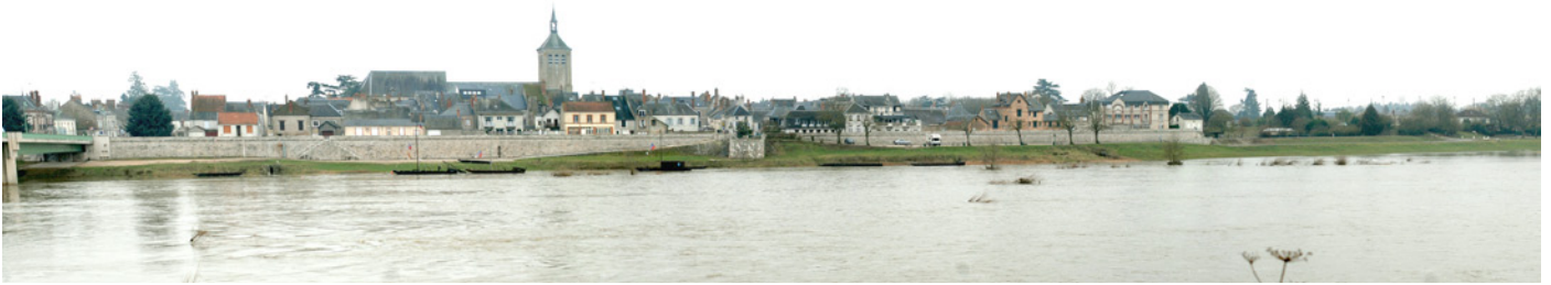
1 . La façade urbaine de Jargeau face à la Loire : Un perré maçonné continu souligne la façade cadrée par des espaces boisés en bord de Loire.
