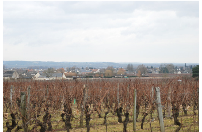
4. Un territoire viticole peu à peu mité par l'urbanisation progressive des terrasses.
