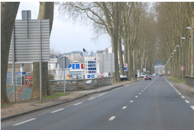
4. Dégradation de la RD 116 et de l'entrée de ville de Chinon par des constructions en bordure de route.
