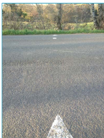
Passage busé sous la RD 34
