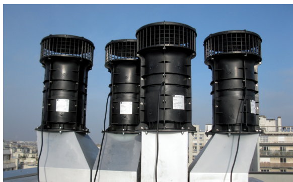
Conduits de ventilation naturelle assistée
