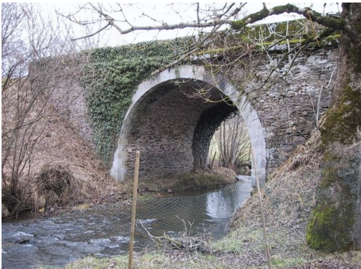
(Pont des Granges à ARPAJON/CERE)
