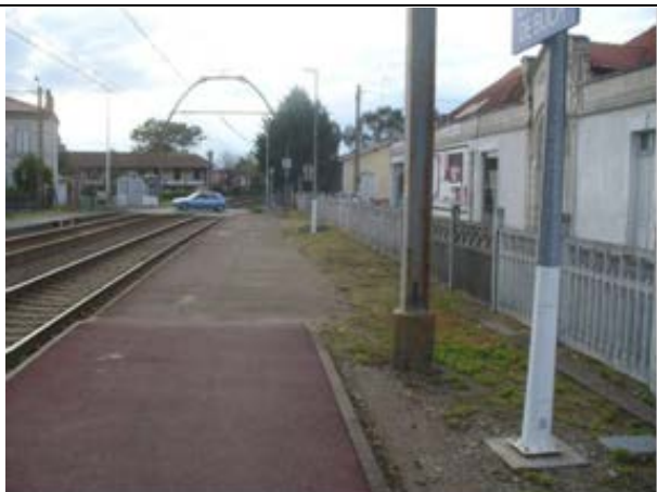
Photo 15 – Extr mit  quai n 2 direction Arcachon
