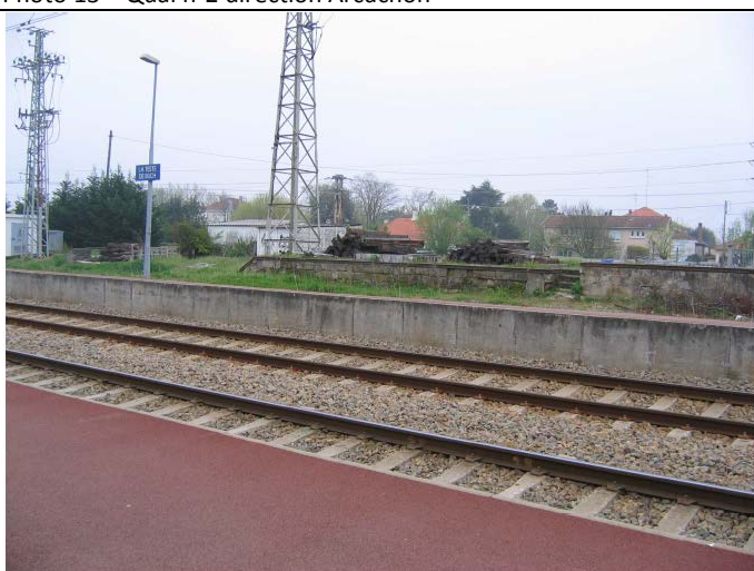
Photo 15 : Vue sur quai n°2
