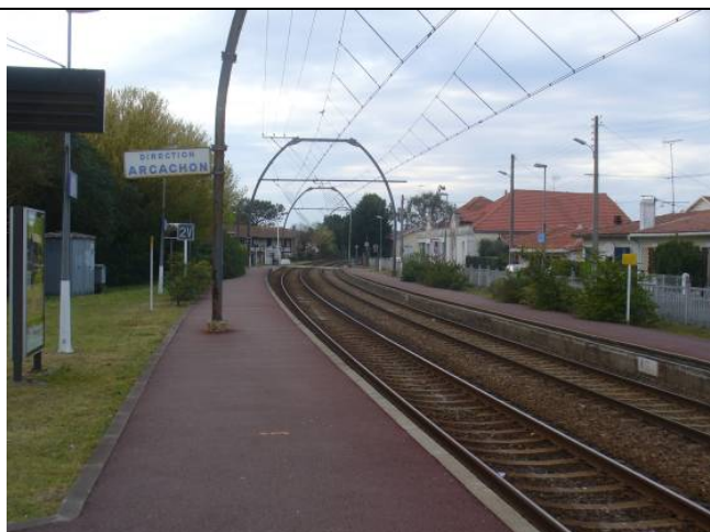
Photo 11 : Quai n°1 direction Arcachon
