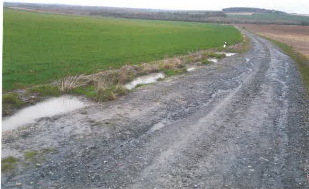
Fossé à redents
