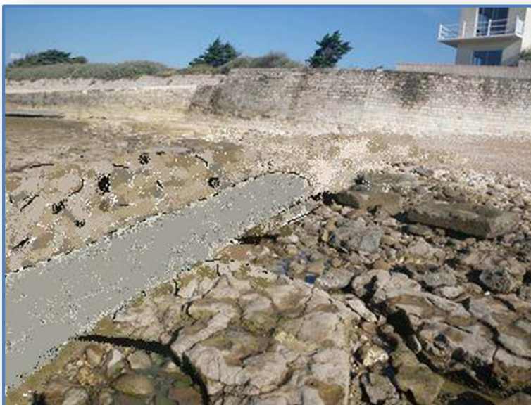
Figure 7 : Impact visuel après travaux
