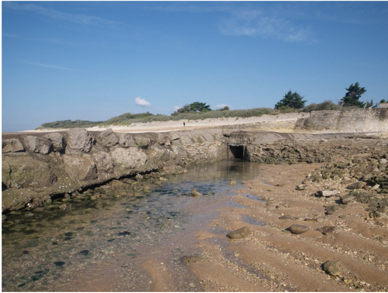
A gauche : sortie de l'ouvrage de La Perroche
