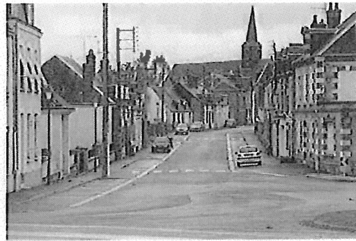
Image n°2 : Vue de l'Avenue de la gare
