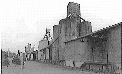
Image n°9 : Silos agricoles en activité
