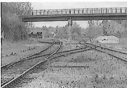
Image n°34 : Vue de la base travaux actuelle en direction de Courtalain
