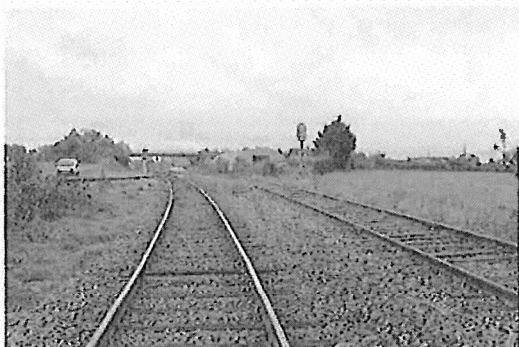
Image n°35 : Vue depuis les voies en direction de la base de Courtalain
