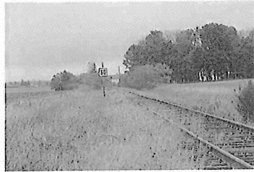
Image n°30 : Croisement voie ferrée/route en direction du lieu-dit l'herbage, vue direction Courtalain
