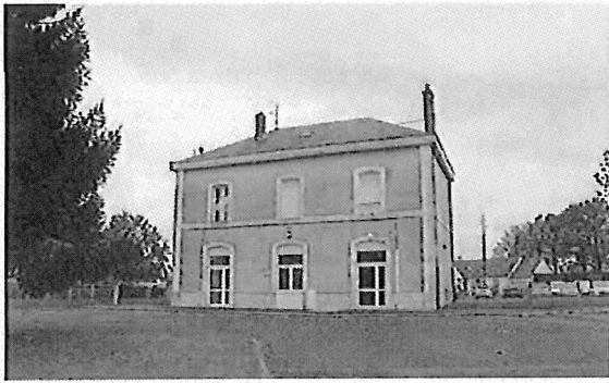
Image n°1 : Vue de l'ancien bâtiment voyageur de la gare de Droué*
