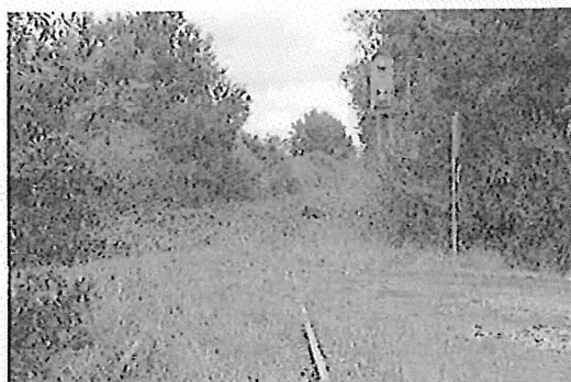
Image n°39 : Croisement voie ferrée/lieu-dit la Montpointière
