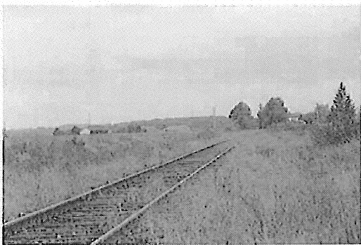
Image n°29 : Croisement voie ferrée/route en direction du lieu-dit l'herbage, vue direction Droué
