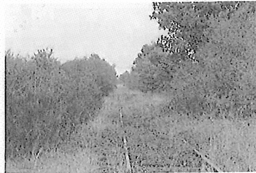
Image n°28 : Croisement voie ferrée/D141, direction Courtalain
