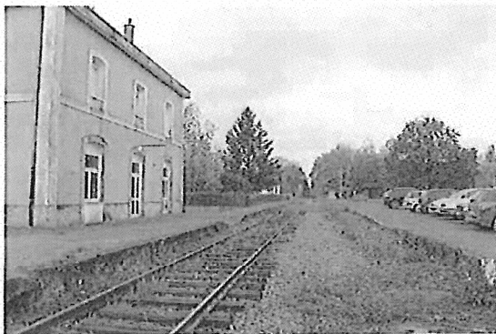
Image n°3 : Vue de la voie existante en direction de Mondoubleau
