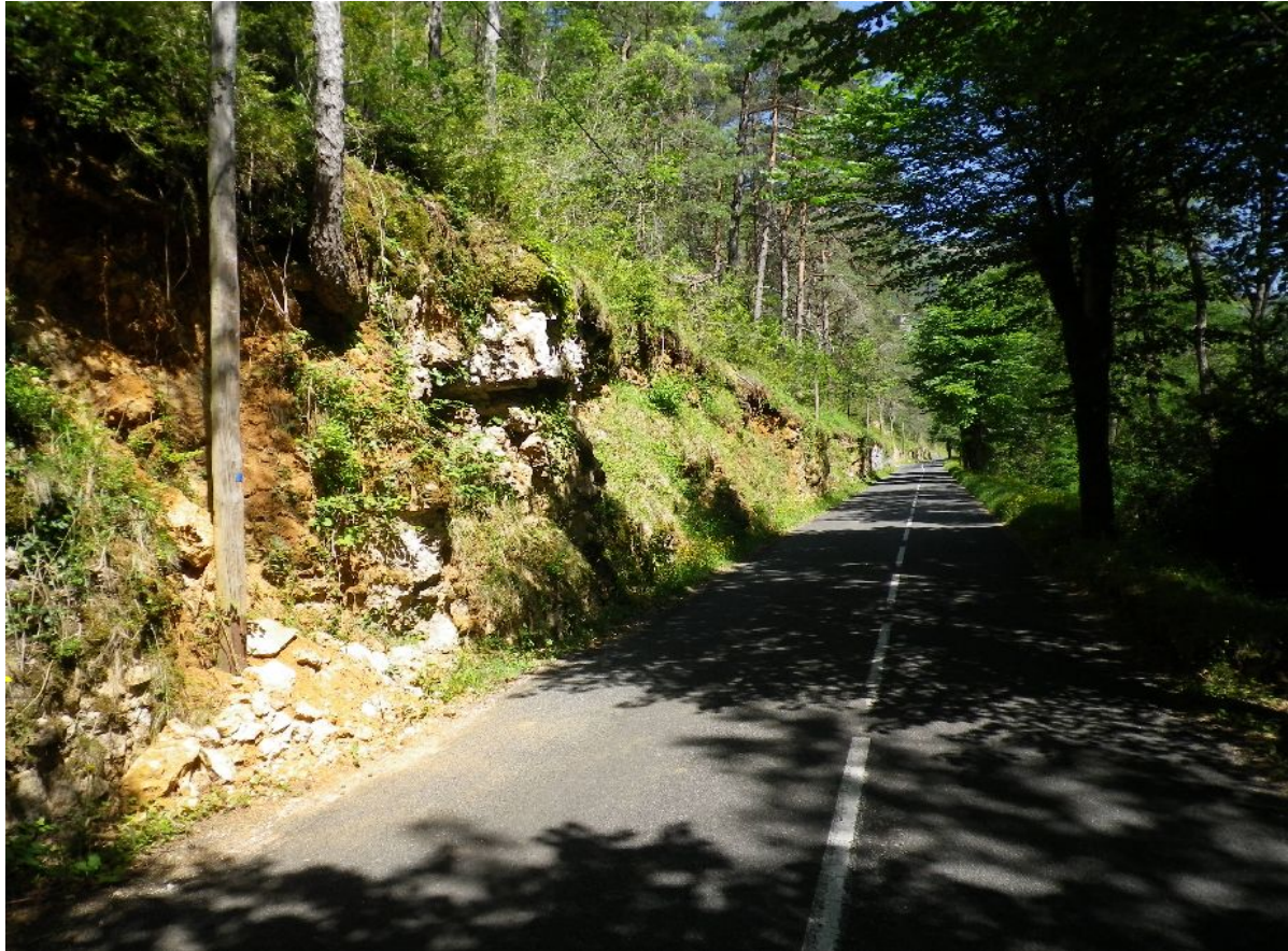
Au niveau du profil 40 (vers le 41)
