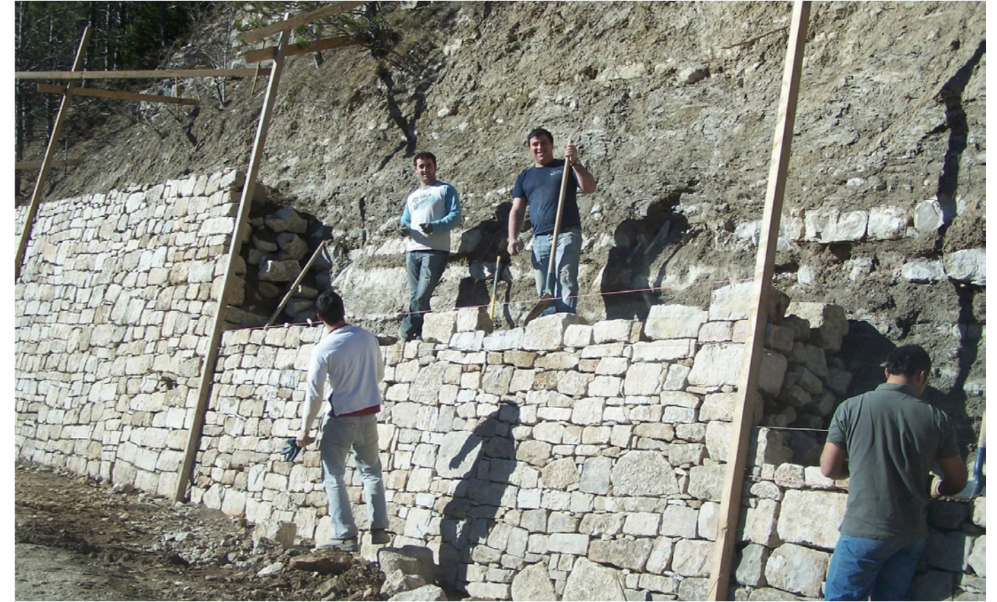
Construction d'un mur de soutènement. Un savoir-faire traditionnel transmis par les aménagements de la route des gorges.
