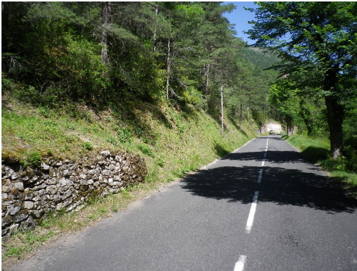
Au niveau du profil 92 (vers le 93)
