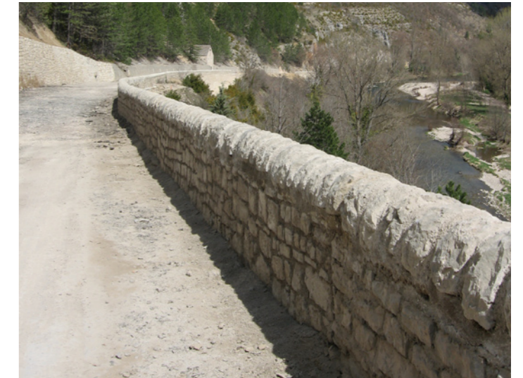
Exemple de mur reconstruit avec libage ou chaperon arrondi en pierres calcaires.
