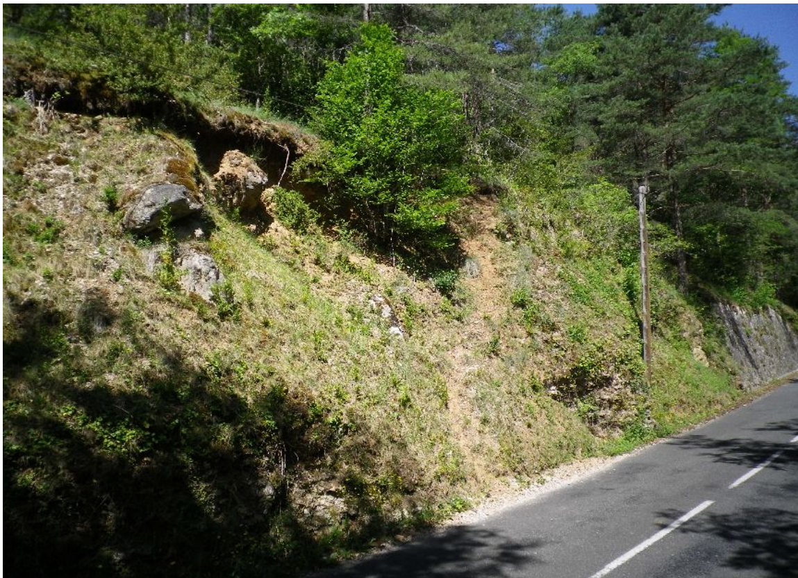
Talus amont des profils 53 à 58
