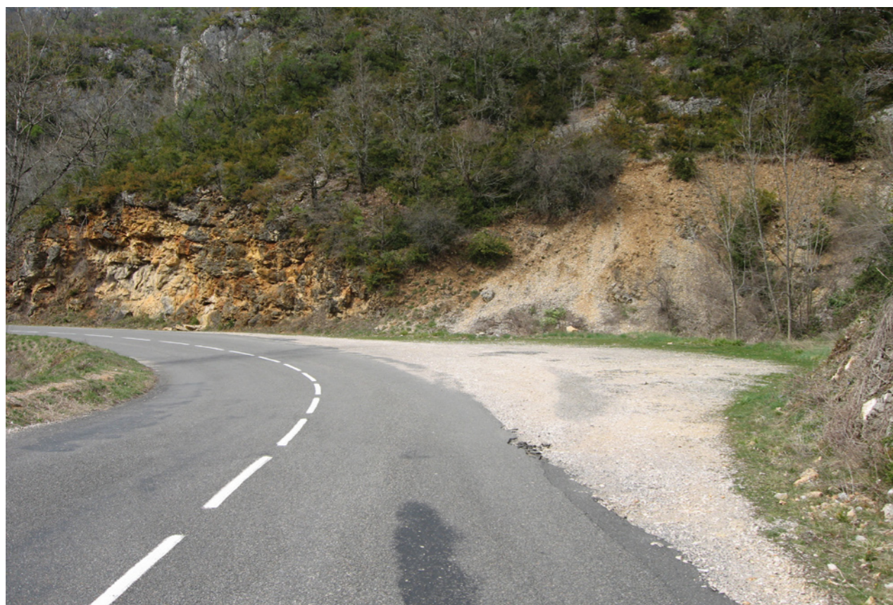
Le passage des Détroits: les parapets s'insèrent parfaitement dans le site. Le chasse-roue, construit en pierres calcaires, s'interrompt devant un rocher naturel avant qu'un parapet en pierre ne prenne le relais.
