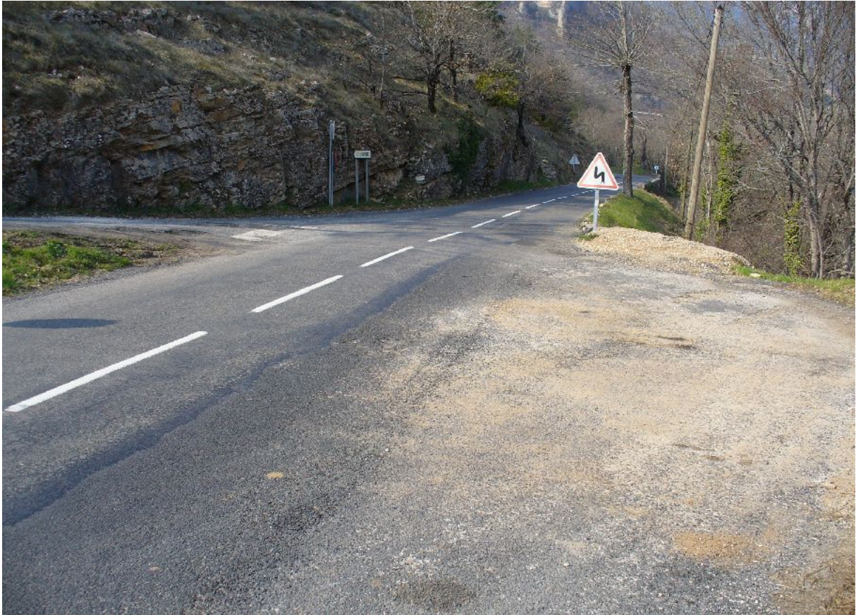
Au niveau du profil 154 (vers le 155)
