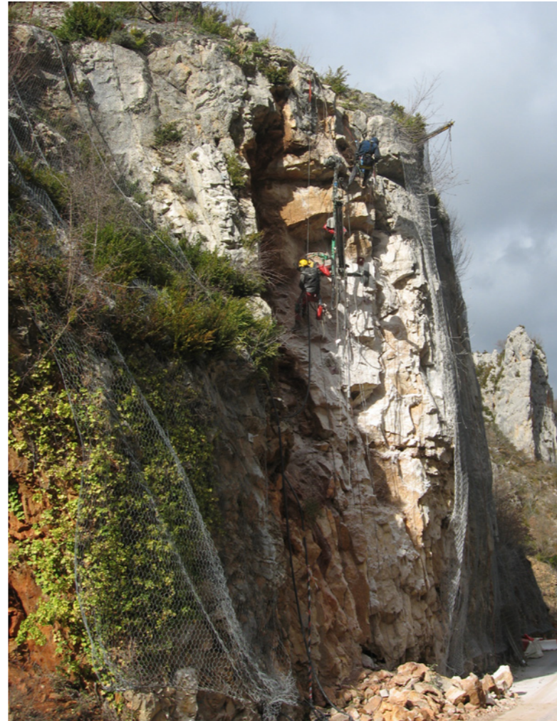
Travaux de sécurisation de falaises à l'aide d'un grillage le long de la D 907bis
