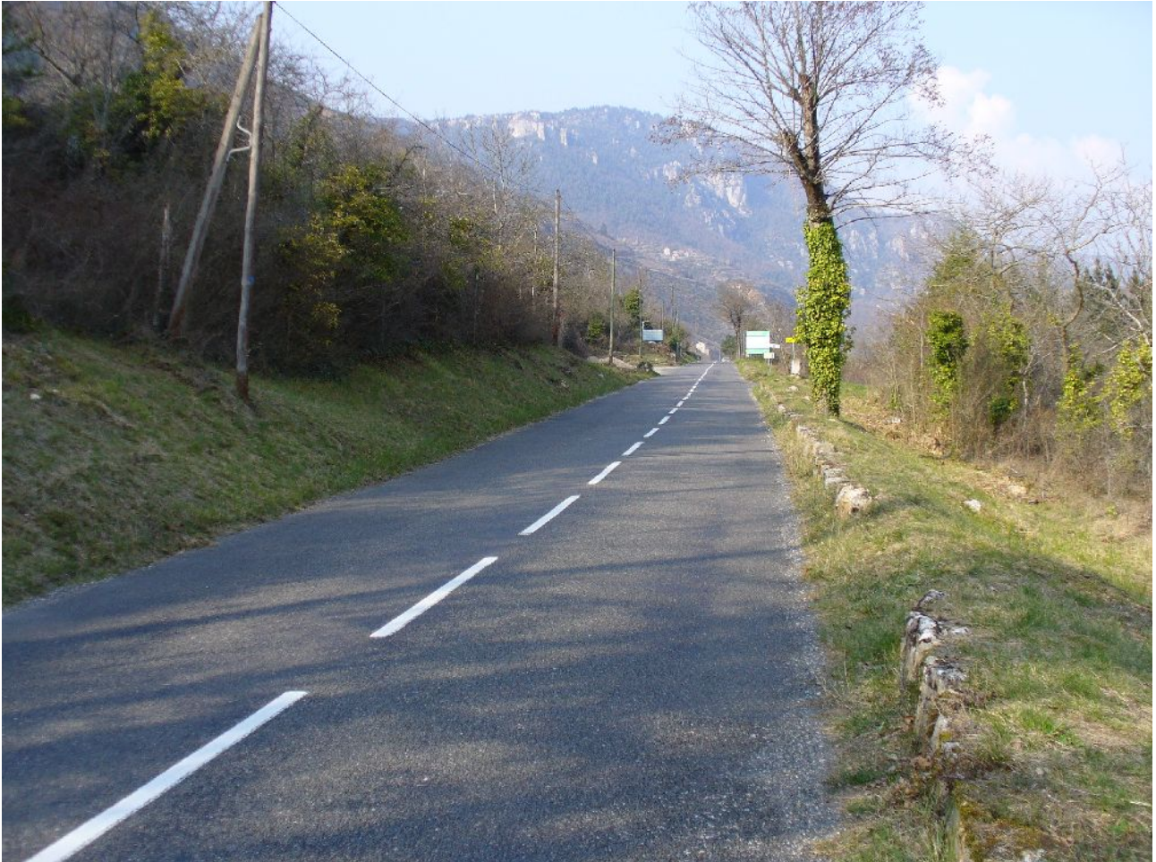
Au niveau du profil 125 (vers le 126)
