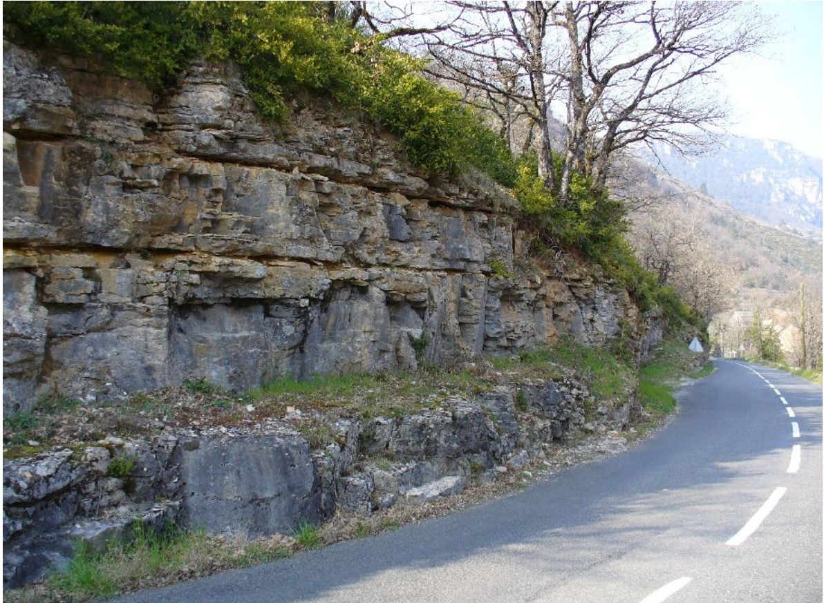
Au niveau du profil 176 (vers le 177)
