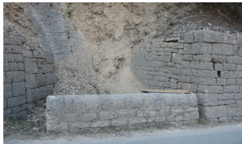
Les murs de soutènement forment un discret retournement dans lequel s'inscrit un petit ponceau construit selon le vocabulaire traditionnel des Gorges du Tarn.
