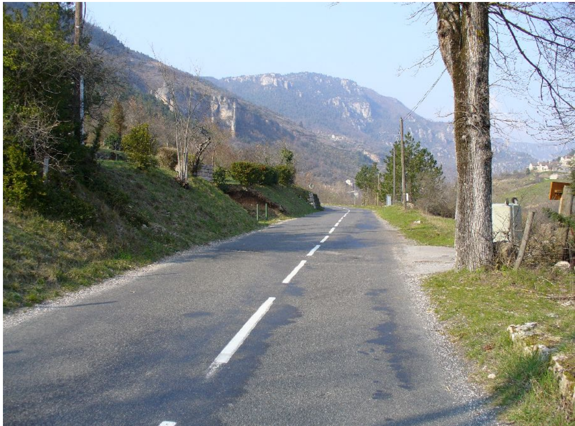
Au niveau du profil 137 (vers le 138)
