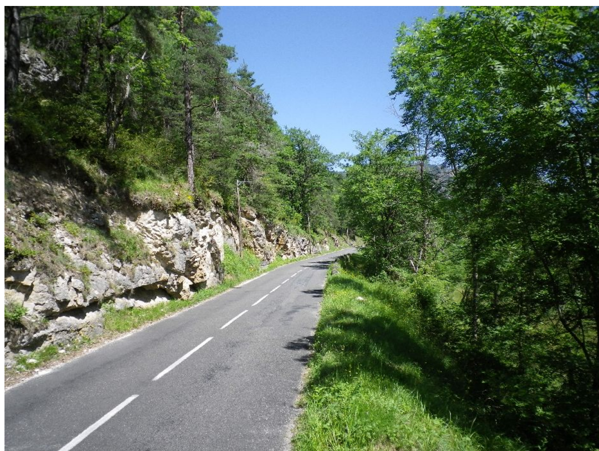
Au niveau du profil 104 (vers le 105)
