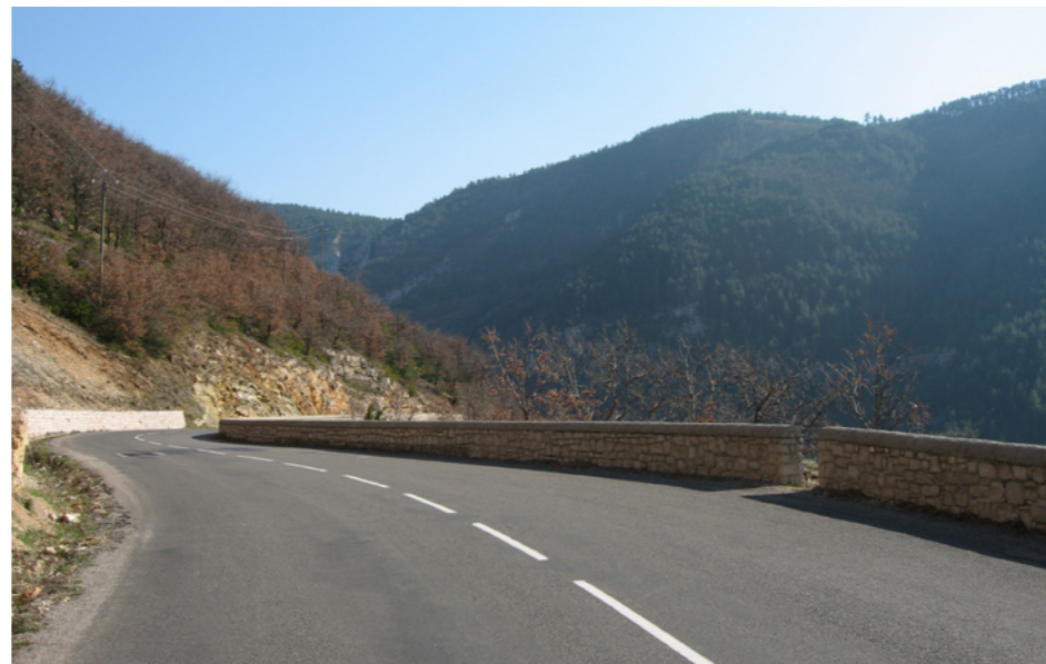
Lors des aménagements réalisés en 2001, en amont de Prades, quelques petites excroissances de la route ont été ménagées pour permettre le croisement des véhicules.
