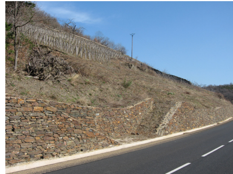
Rampes croisées utilisant le schiste réalisées en 2008 en aval de Faux.
