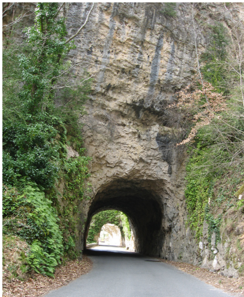
Succession de trois tunnels dans le site des Baumes Hautes. La route (D.907 bis) se rétrécit pour passer sous les falaises calcaires. Ici la chaussée a conservé une largeur minimale. Le site et la route s'associent pour former le paysage des gorges.
