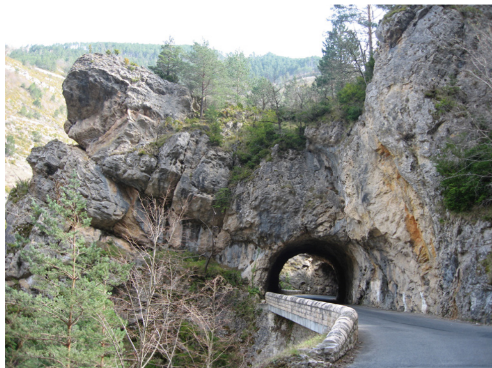
Une succession de deux tunnels à l'aplomb de Saint Chély. Passage discret de la chaussée en encorbellement.
