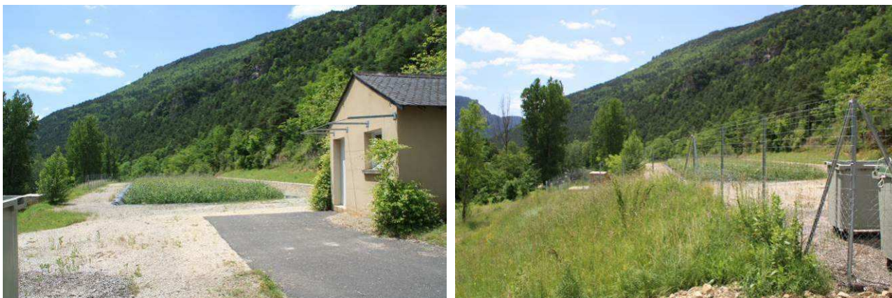
Station d'épuration des Vignes
