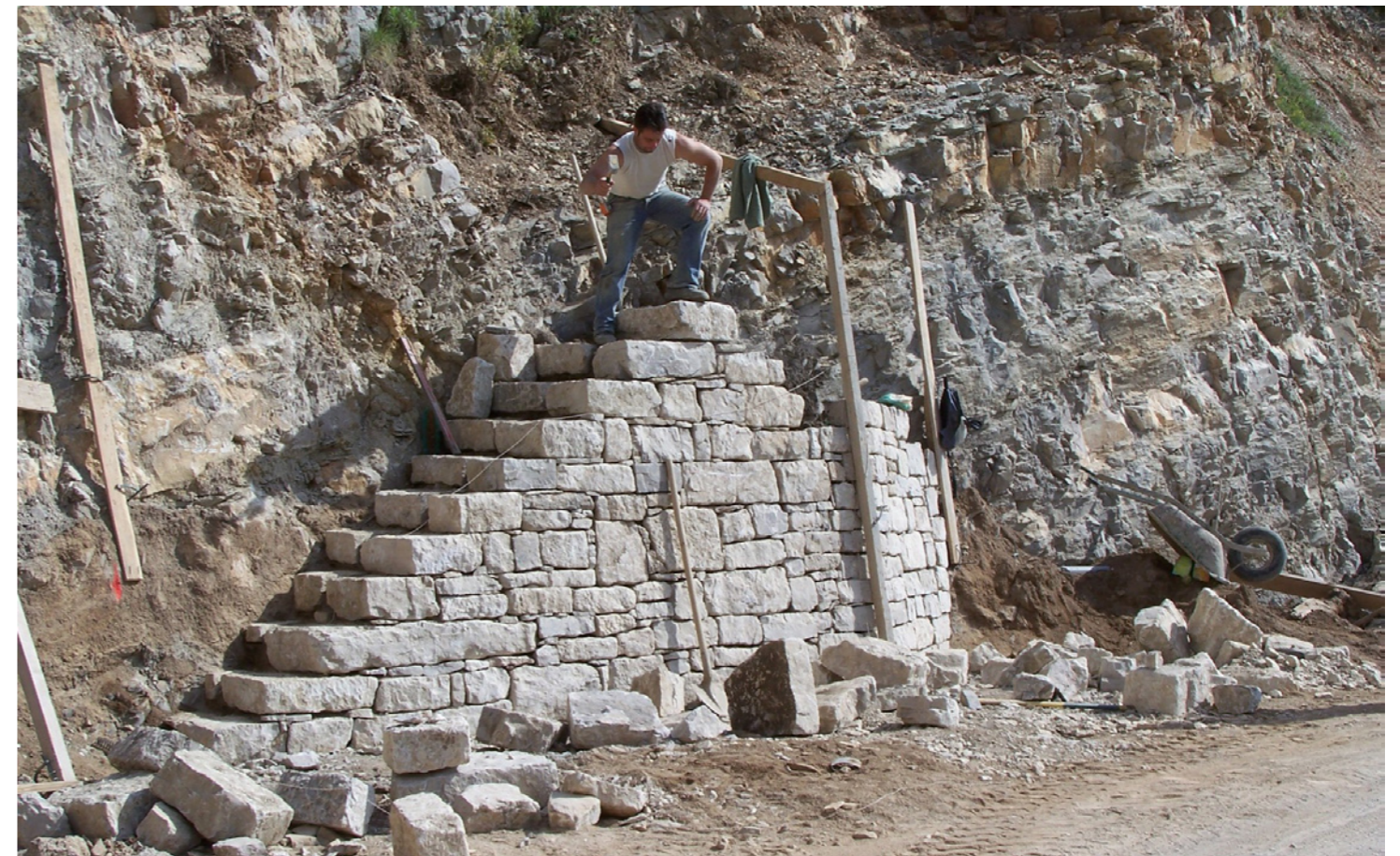
Exemple de rétablissement d'un accès en escalier.
