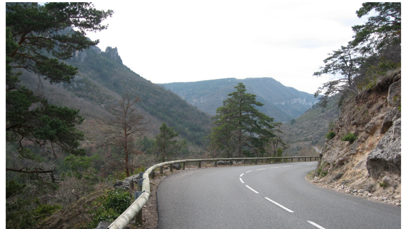
Dans le contexte boisé des Gorges de la Jonte, l'usage de la glissière en bois est pertinent et s'inscrit harmonieusement dans le paysage.
