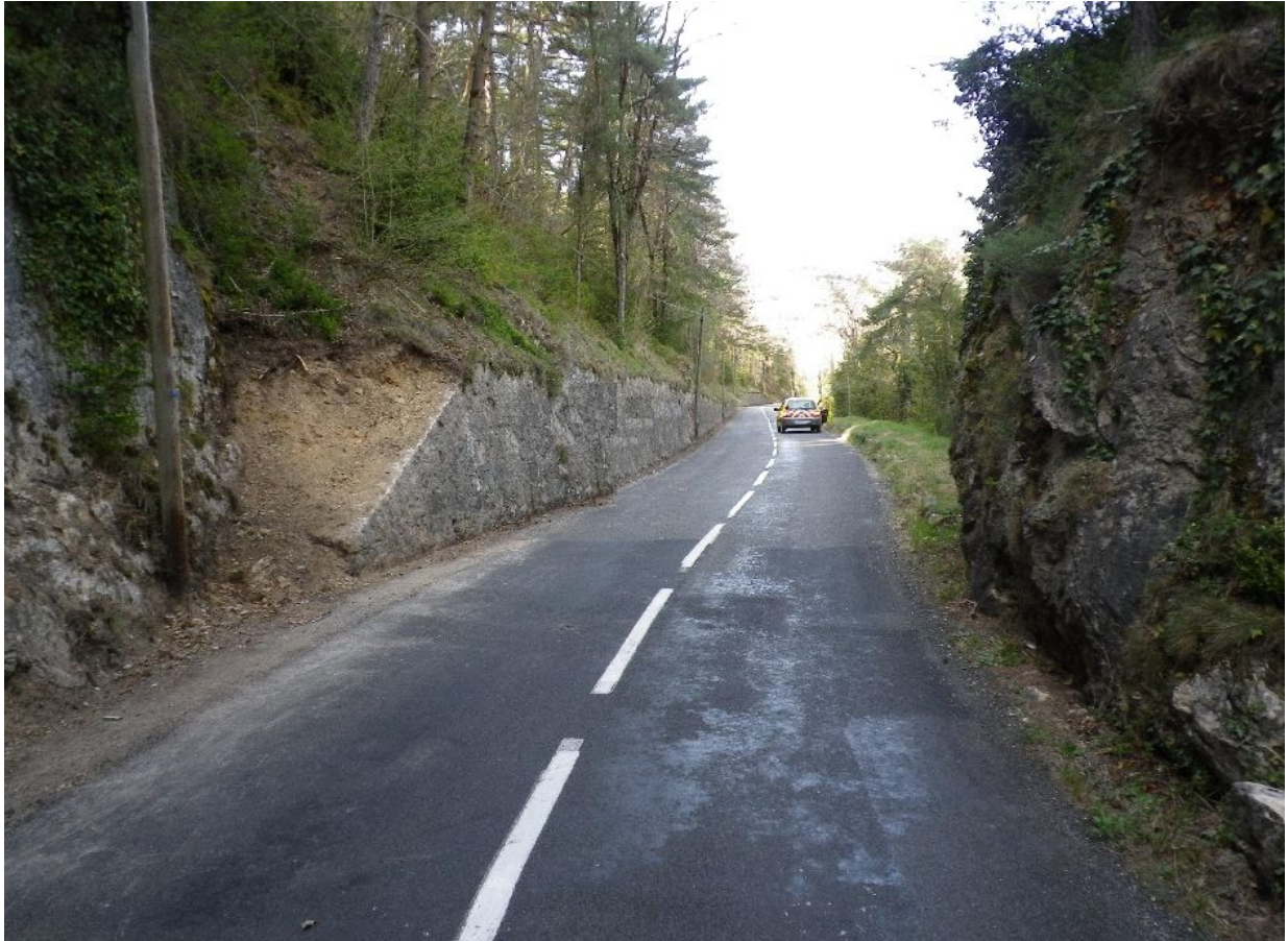
Au niveau du profil 9 (vers le 10)
