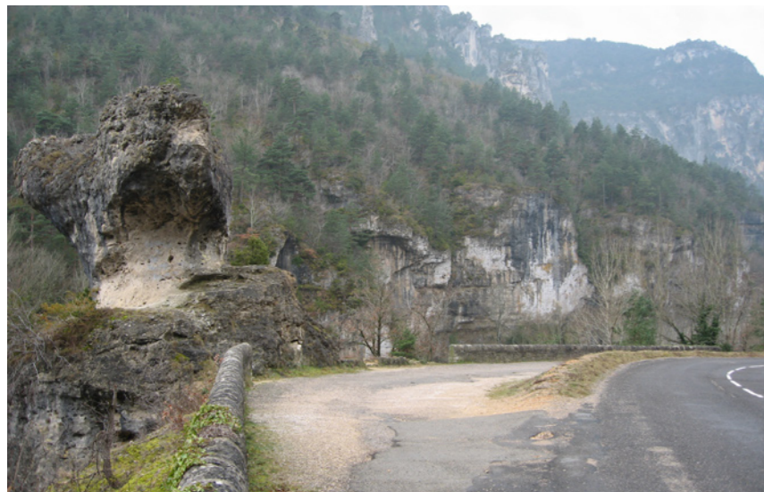
Belvédère du Champignon, excroissance de la chaussée dont l'aspect s'avère un peu trop négligé pour signifier une aire de stationnement.
