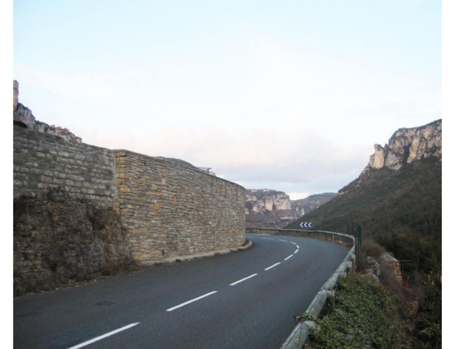
Le belvédère des Vautours dans les Gorges de la Jonte est situé à l'arrière du mur de soutènement. Les matériaux utilisés et la forme générale du belvédère s'intègrent bien au paysage de terrasses des gorges.
