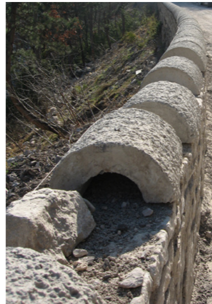
Détail du béton reconstitué utilisé pour couvrir les parapets. La forme arrondie caractéristique et la couleur claire sont respectées.
