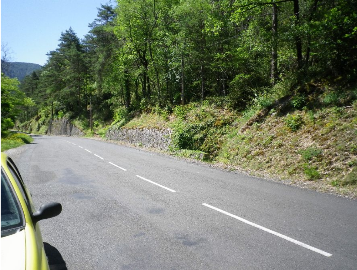
Au niveau du profil 65 (vers le 64)
