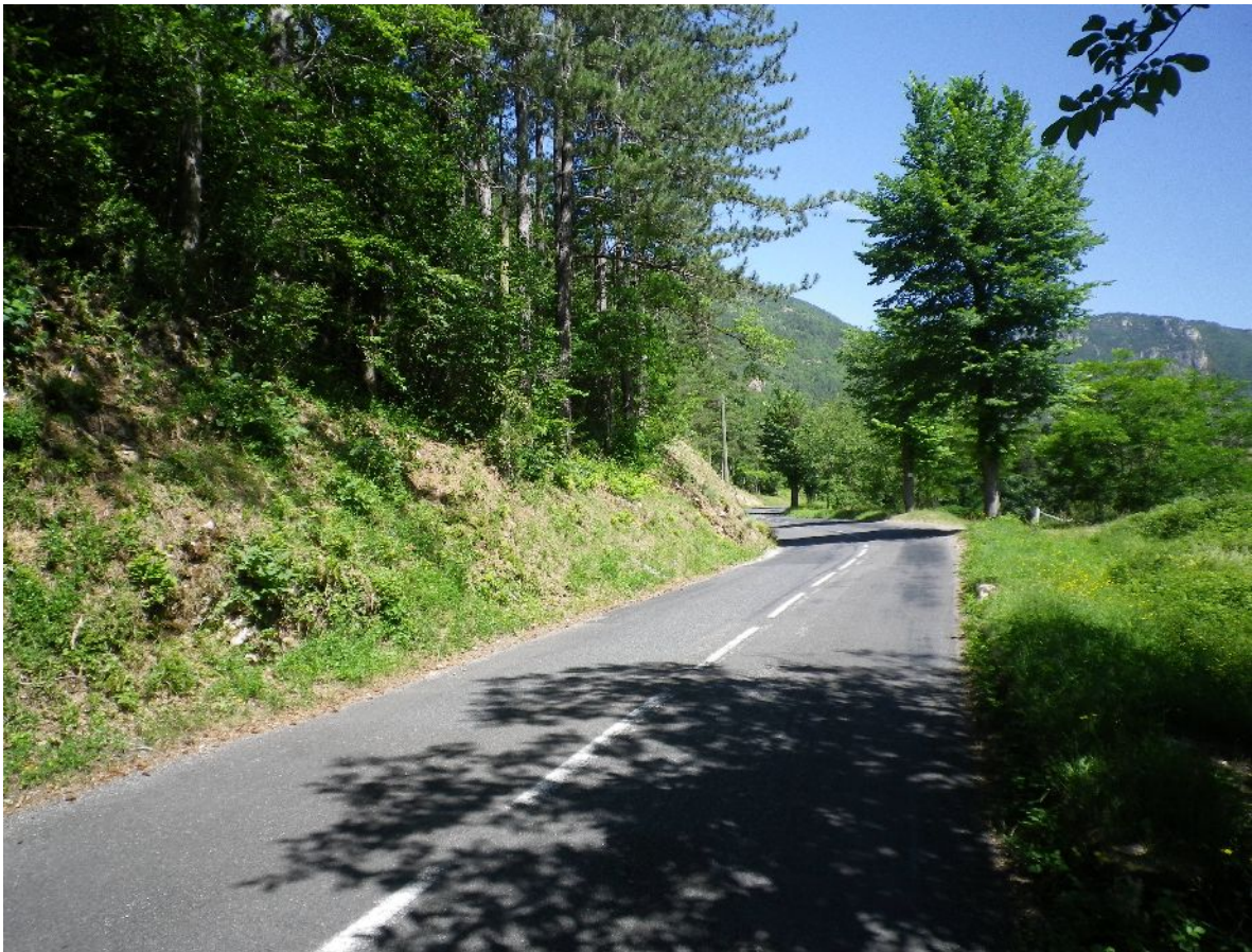
Au niveau du profil 72 (vers le 73)
