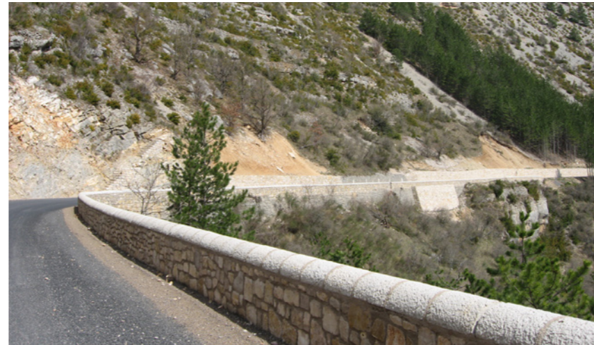
Parapet construit en 2008, en amont de Blajoux. Les pierres utilisées sont locales et le béton reconstitué de couleur claire entre dans la palette générale du site.
