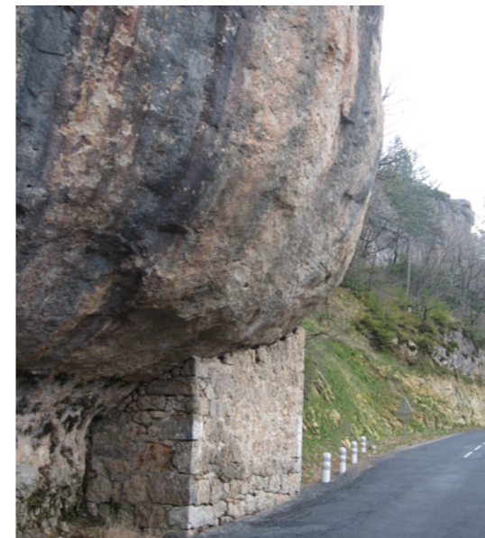
Aménagements ponctuels à la sortie sud de Sainte Enimie le long de la D.986 Cet aménagement accueille discrètement un petit local dont la porte se situe à l'arrière.
