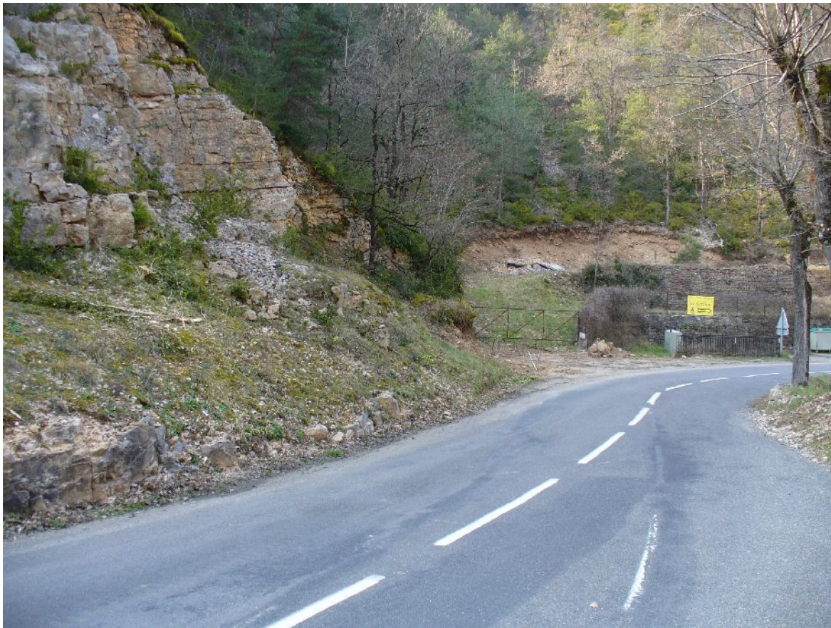
Au niveau du profil 168 (vers le 169)
