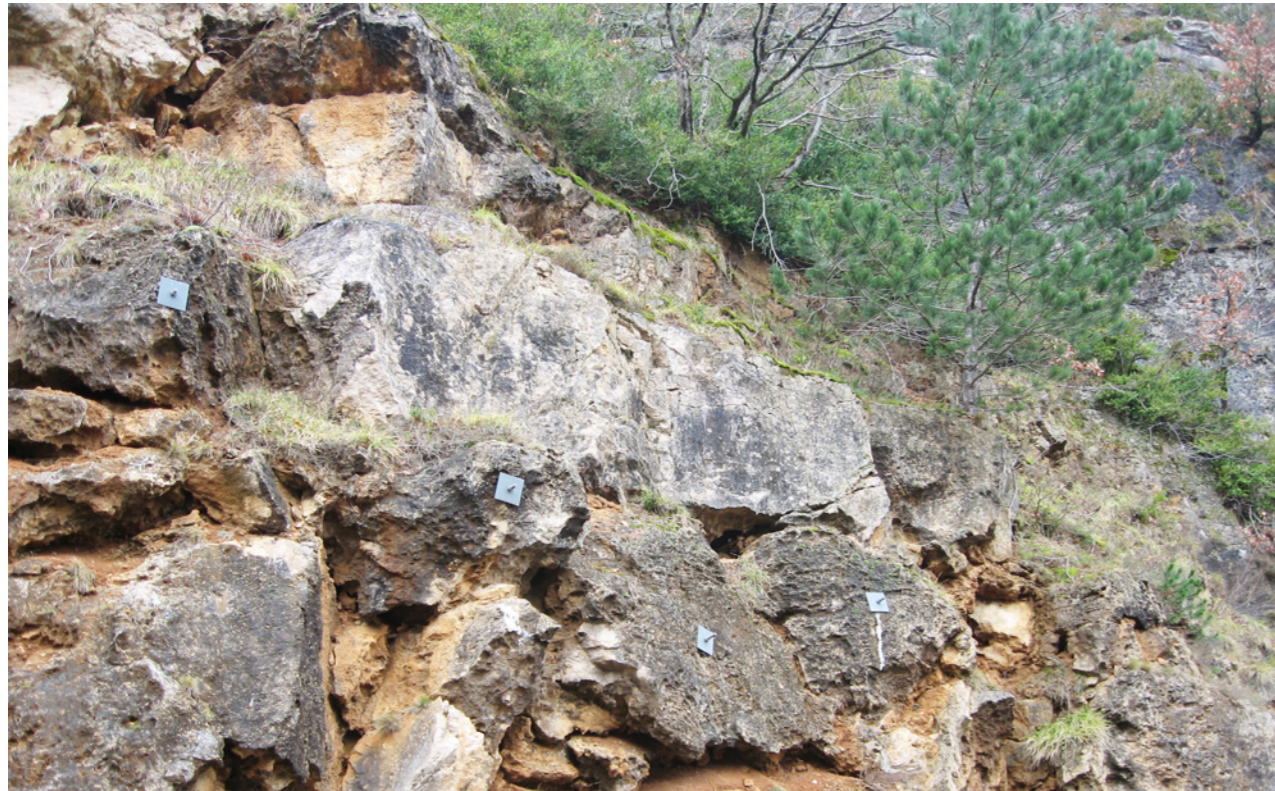
Détail des ancrages qui fixent des rochers disloqués. Ce système permet d'évoquer le travail naturel du temps sur la roche.
