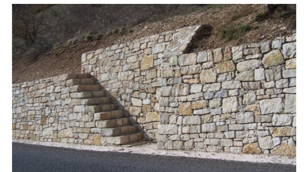
Petit escalier en amont de Blajoux.
