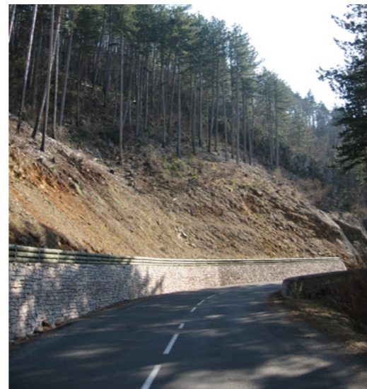
Sur la D 986, vers le Causse Méjean, le soutènement amont est rehaussé de poutres en bois pour arrêter les éboulements de pierres. Dans le contexte boisé de cette pente exposée à l'ubac, l'ensemble forme un dispositif harmonieux.
