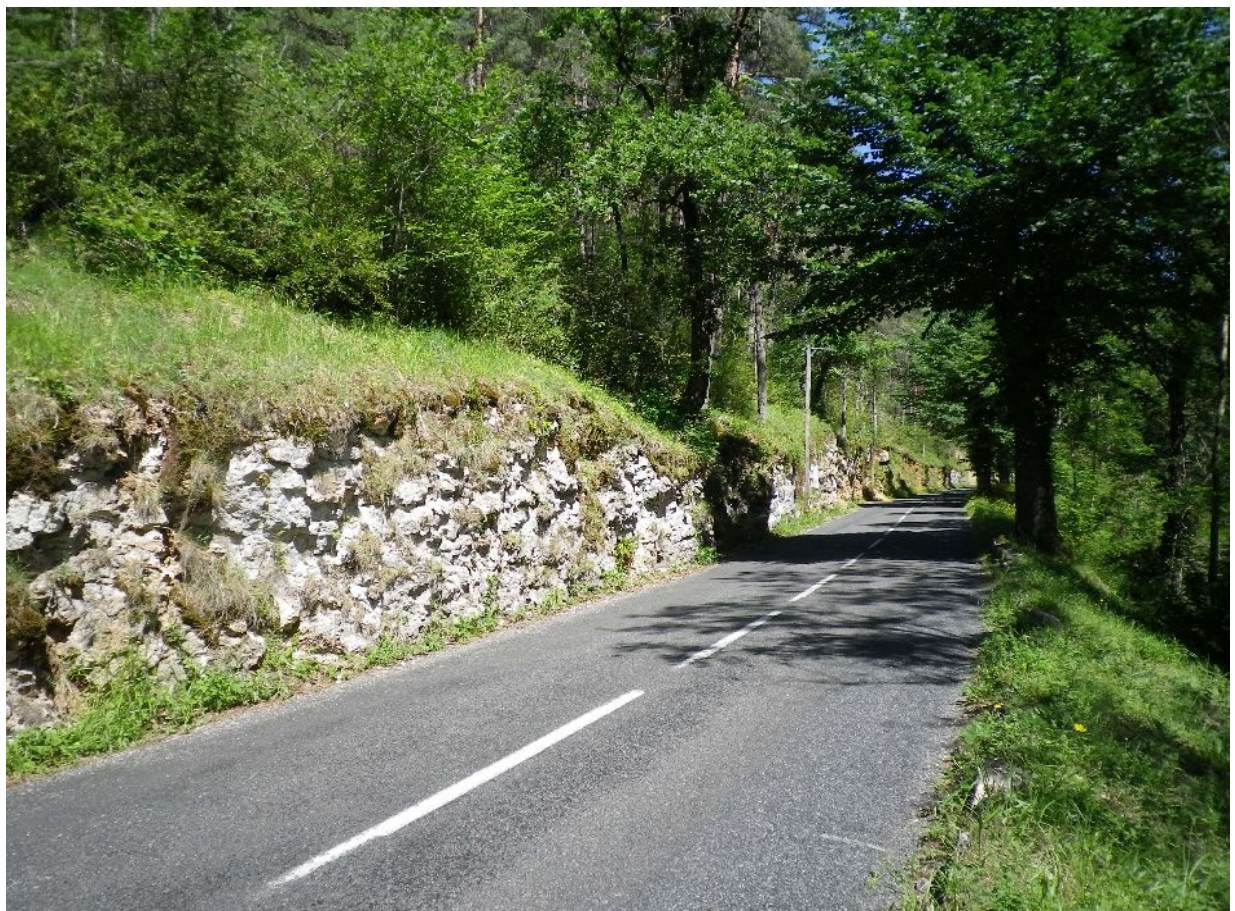
Au niveau du profil 33 (vers le 34)
