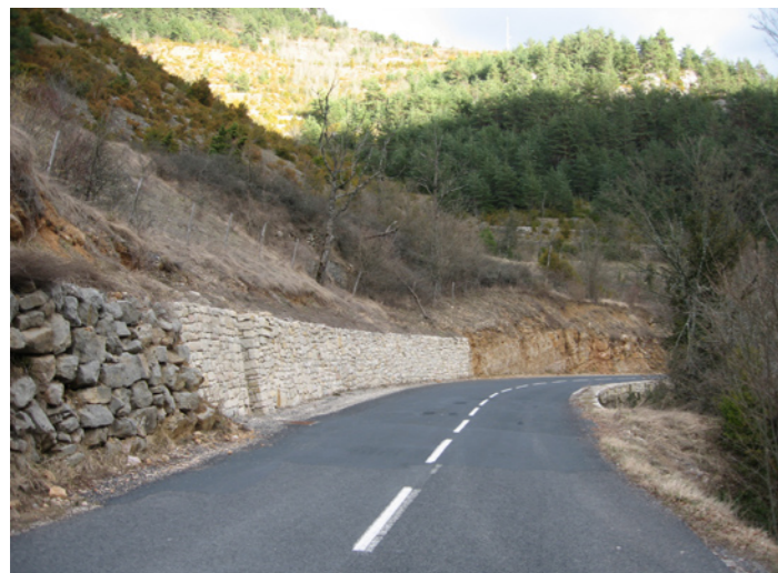
Dans les gorges de la Jonte, à proximité de Capelan, la confrontation de deux soutènements d'époques différentes. Au premier plan, l'enrochement forme un paysage délaissé. A l'inverse, les travaux réalisés en 2005 s'intègrent parfaitement au vocabulaire paysager local.
