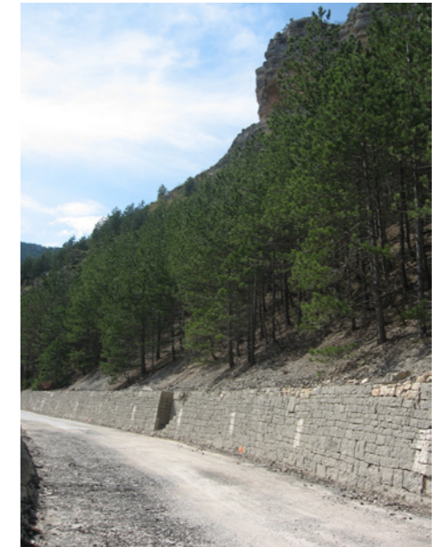
Travaux en cours en face de Montbrun. La couleur de la pierre s'insère parfaitement dans le site. L'aspect «pierres sèches» et le petit escalier ancre ce soutènement dans le vocabulaire local de la terrasse et offre à la route une ligne amont d'une grande pureté.
