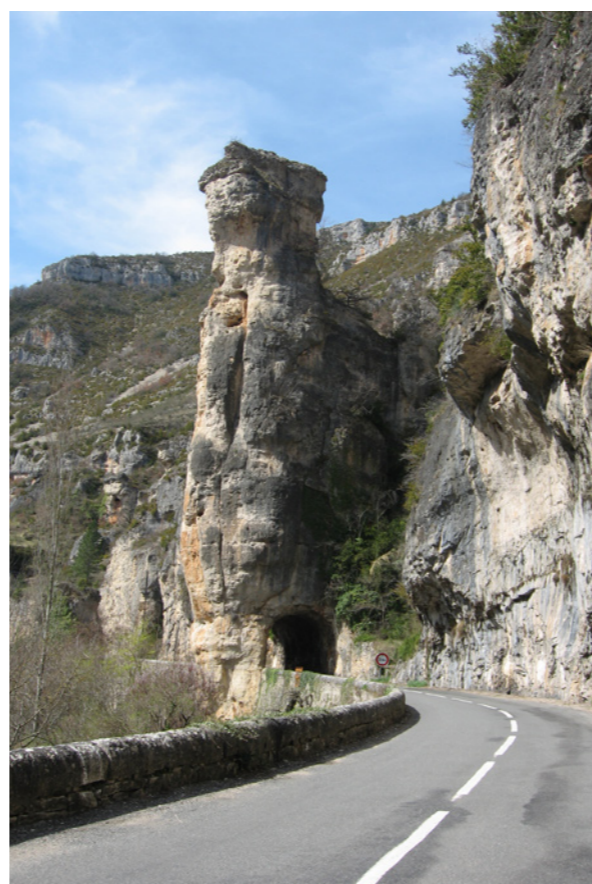
Dans le cirque de Pognadoires, premier tunnel sous une imposante cheminée calcaire.
