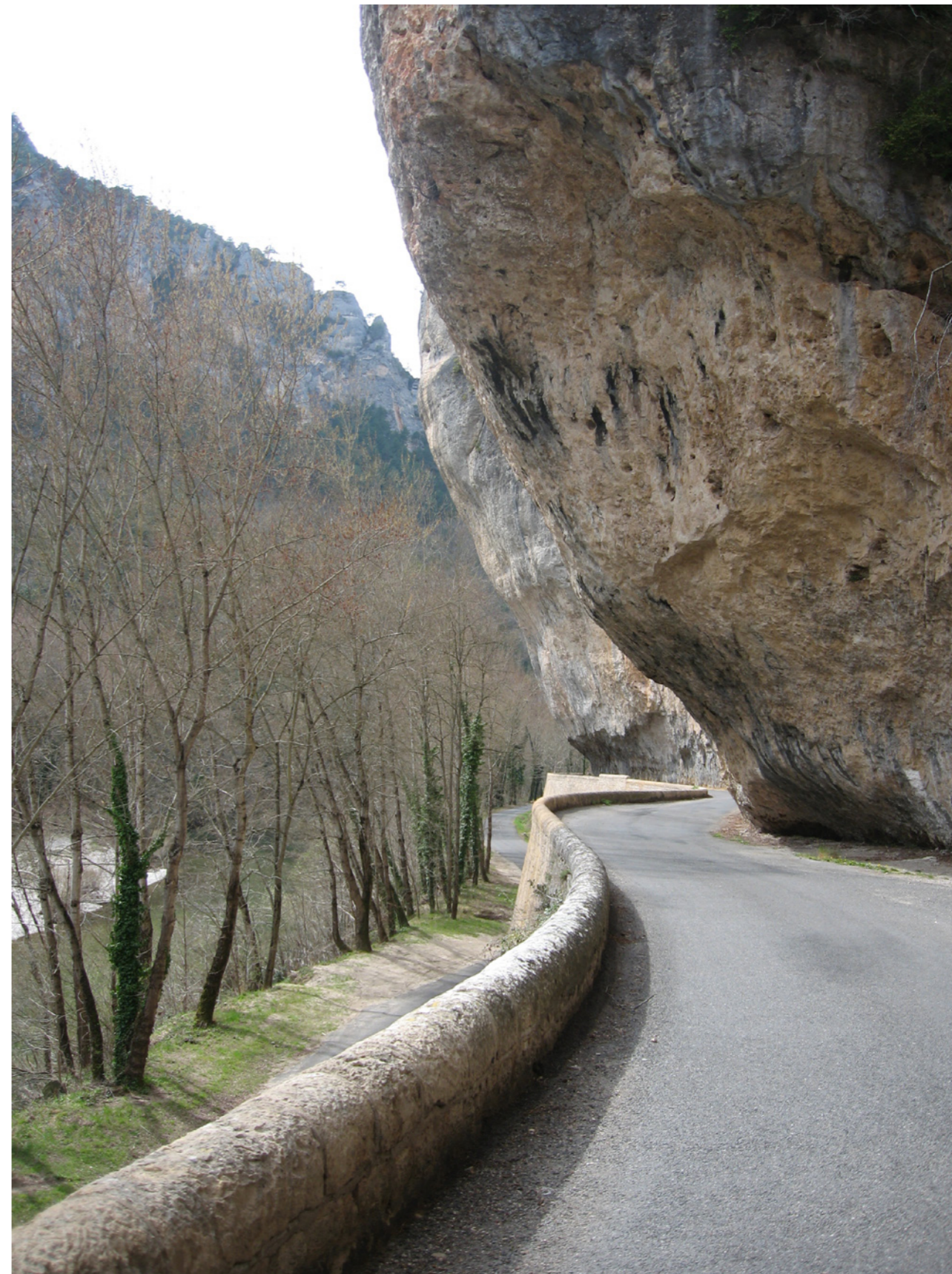
Aux Baumes Hautes, la chaussée se scinde en deux parties pour limiter les terrassements trop importants. Ici, les courbes de la falaise sont respectées et soulignées par le dessin du parapet. Là encore la route et le site s'associent pour former le paysage spectaculaire des Gorges du Tarn.
