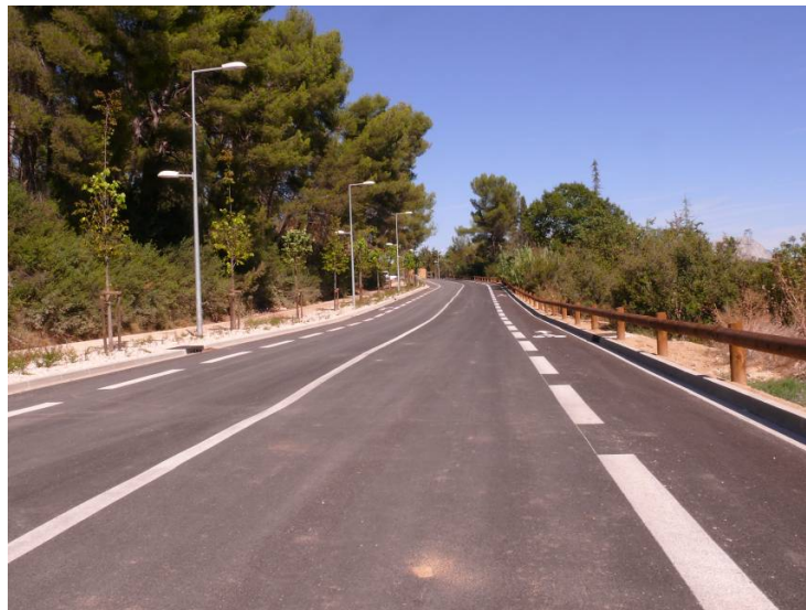
3. Ligne droite sur la route de l'Ensoleillée – tranche 1
