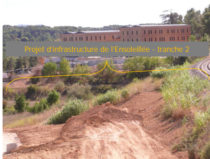
9. Vue de la future voirie depuis le poste source électrique
