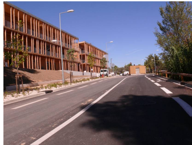
4. La voirie au cœur du quartier de l'Ensoleillée – tranche 1
