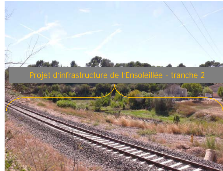
10. Vue de la future voirie au-delà de la voie ferrée
