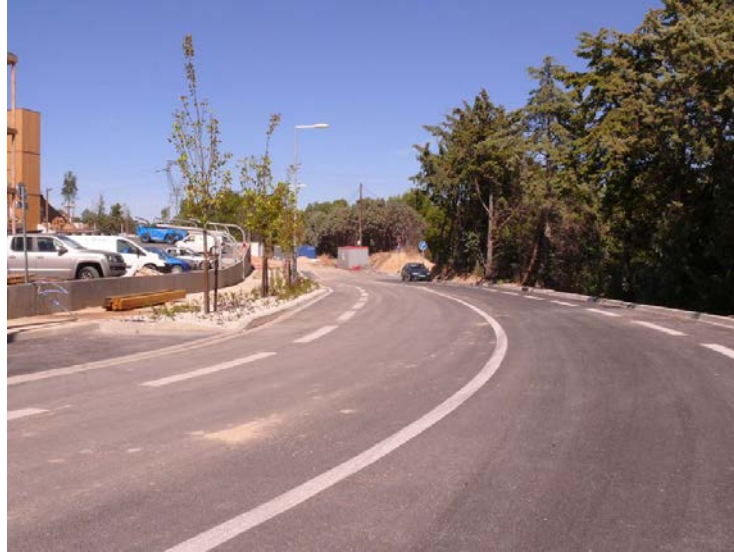
5. Fin du tronçon 1 du quartier de l'Ensoleillée
