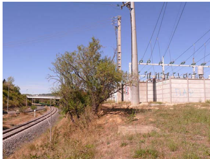
10. Vue des environs - la voie ferrée et le poste source
