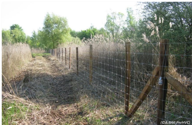
Figure 19 : Exemple de clôture en grillage à mailles progressives
