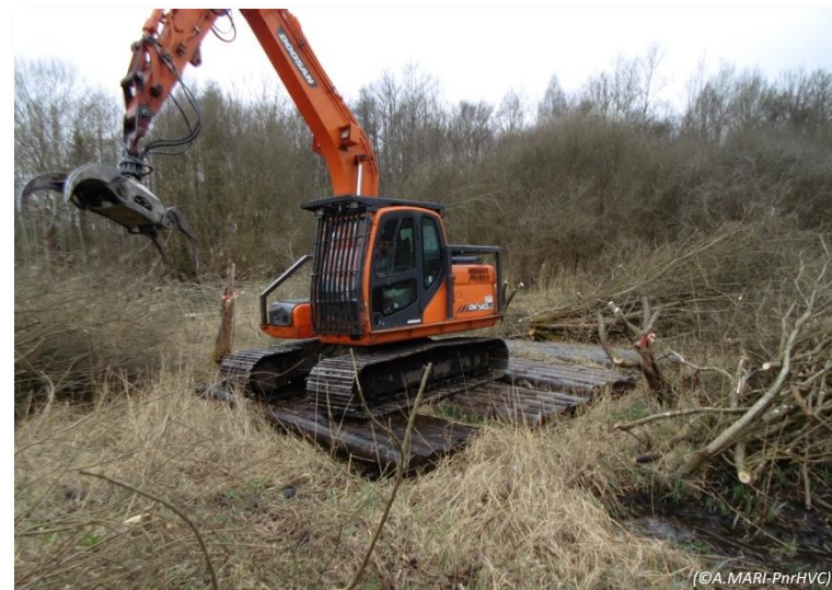
Figure 15 : Pelle mécanique sur plaques de répartition
