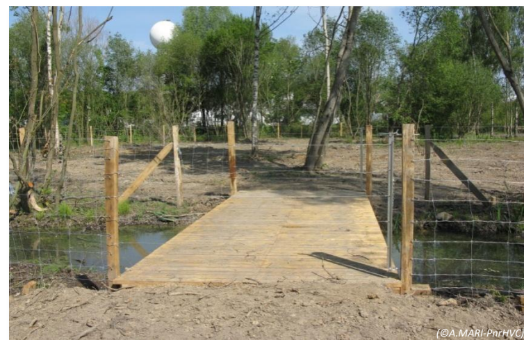
Figure 23 : passerelle en bois pour le franchissement d'un chenal
