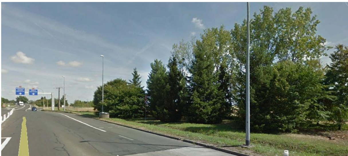
Aperçu du site de puis la barrière de péage de Blois (source : Google Street View)
