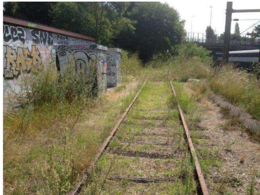
PK 15+770 tiroir 21 vers province
