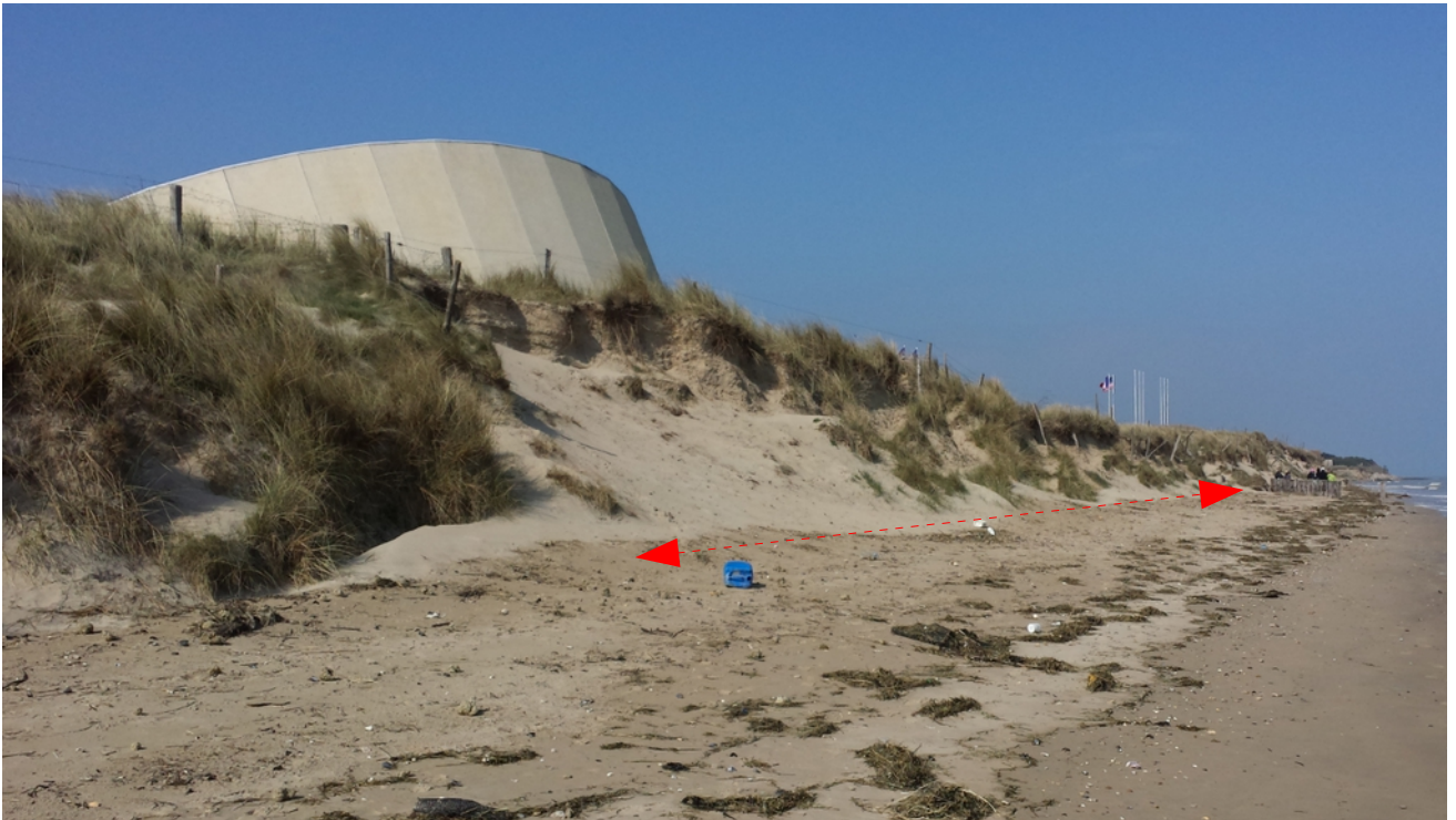
3-a) Photo prise en limite Sud, orientée vers le Nord de la zone de rechargement (mars 2015)
