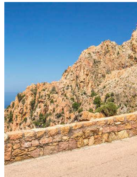
Exemple de Parapet dans les calanches de Piana
