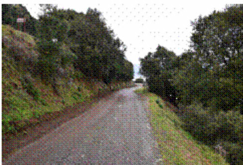
Illustration 102: D624 - La route est à franc de coteau entre un déblai et un remblai. Les croisements sont difficiles (source CEREMA)
