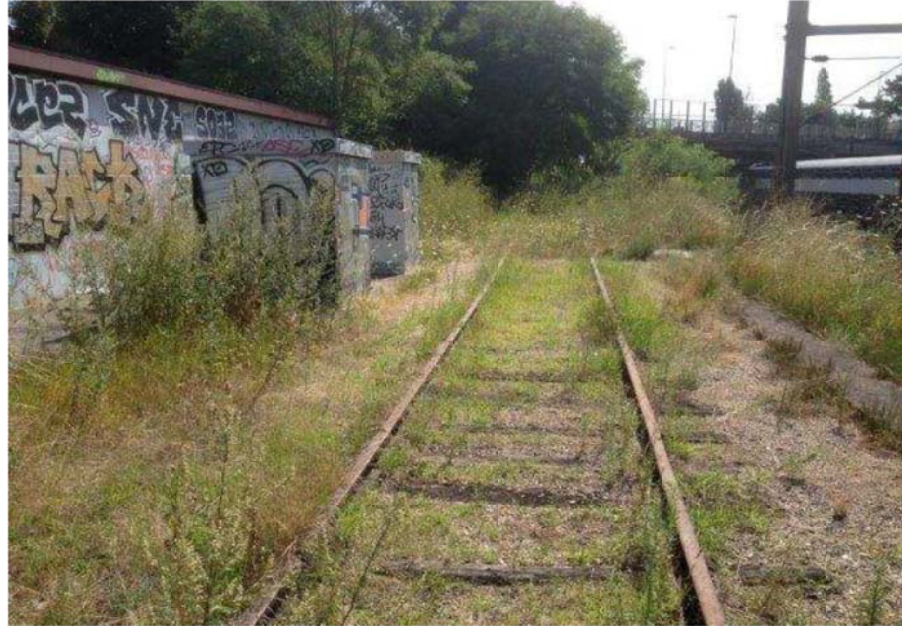
PK 15+775 tiroir 21 vers province
