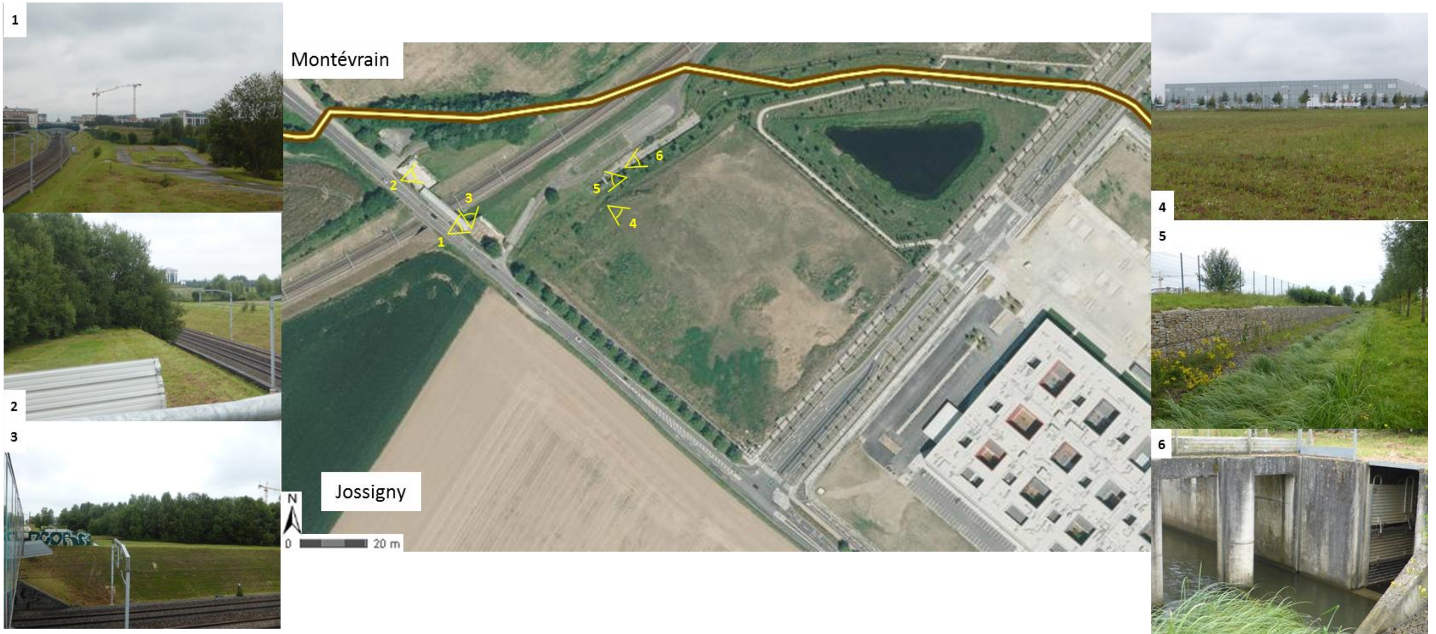
Illustration 5. Prises de vues de l'aire d'étude à proximité du Poste de redressement 3. SYSTRA le 29/07/2014.
