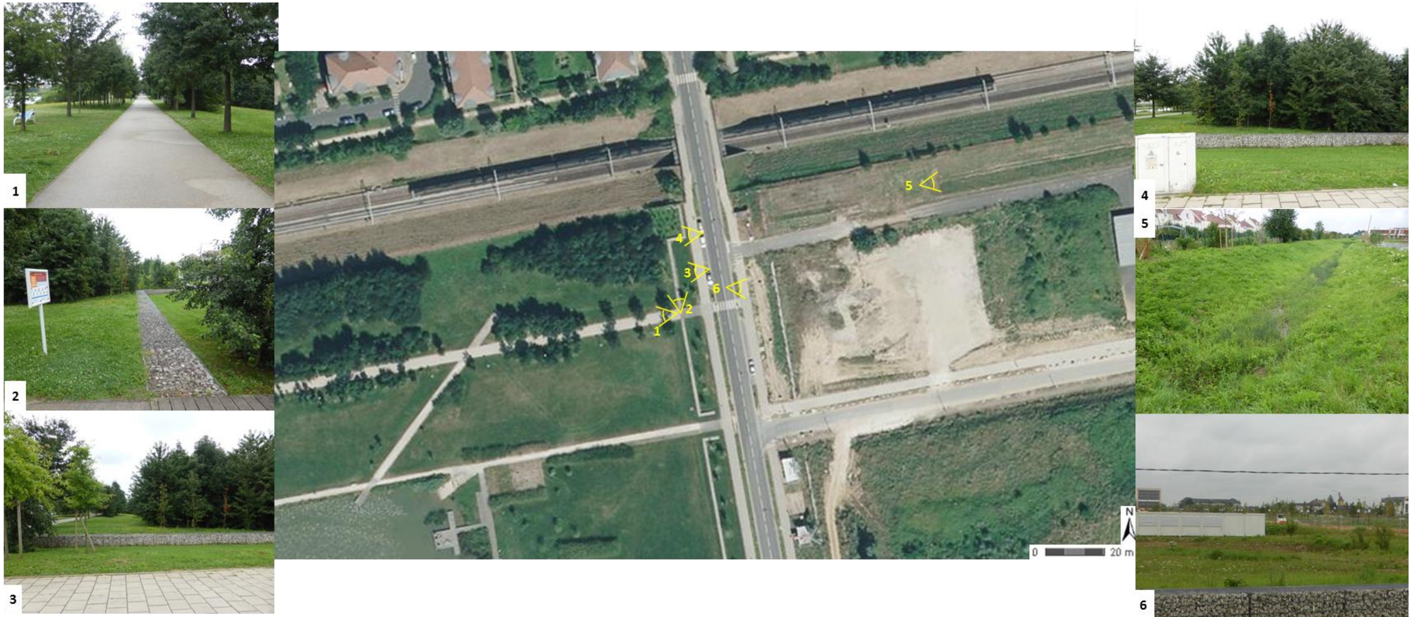
Illustration 4. Prises de vues de l'aire d'étude à proximité du Poste de redressement 2. SYSTRA le 29/07/2014.
