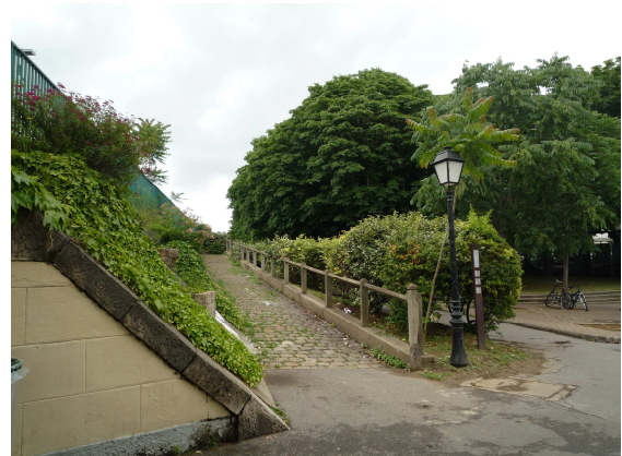
- Photo n°11 : Espace entre la place Jean Moulin et les quais en direction de Paris - (Projet : Localisation de la future rampe permettant l'accès PMR au futur passage souterrain)
