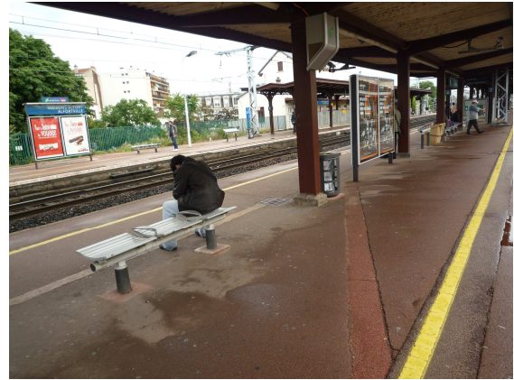
- Photo n°10 : Quai 3 en direction de Malesherbes - (Projet : Localisation des débouchés du futur passage souterrain sur le quai à rehausser)
