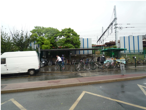
- Photo n°8 : Vue depuis l'avenue du Général Malleret-Joinville en direction du parking à vélos et des quais - (Projet : Localisation du débouché du futur passage souterrain côté Alfortville)
