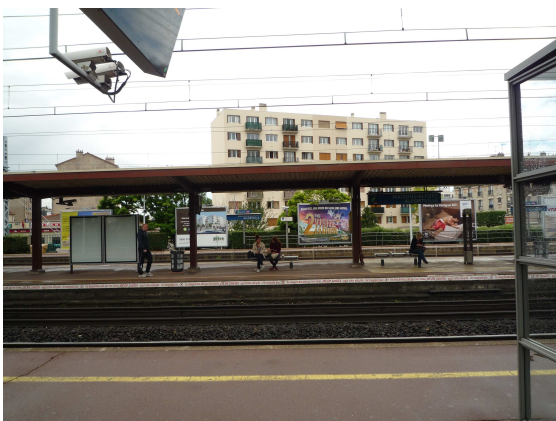
- Photo n°9 : Vue depuis le quai 2 en direction du quai 3 - (Projet : Localisation des débouchés du futur passage souterrain sur le quai à rehausser)
