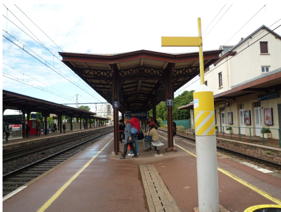
- Photo n°3 : Quai n°2 en direction de Paris -
