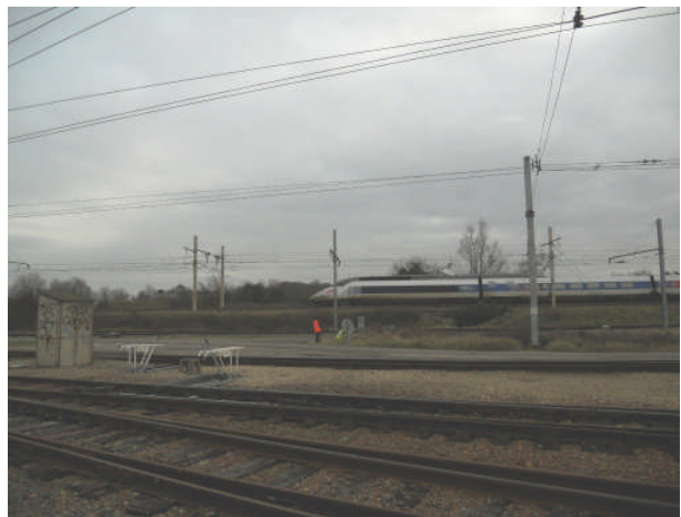
Figure 5 : Extrémité nord du site de Sabarèges, vue 4, source SYSTRA
