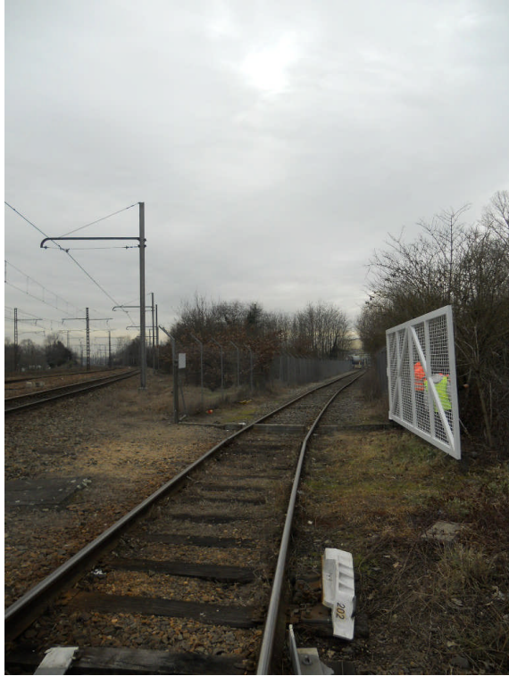
Figure 14 : Entrée de l'ITE Michelin, vue en direction du site Michelin, vue 13, source SYSTRA
