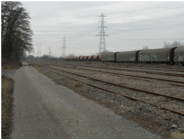
Figure 2 : Faisceaux de Sabarèges, vue en direction de l'ouest, vue 1, source SYSTRA
