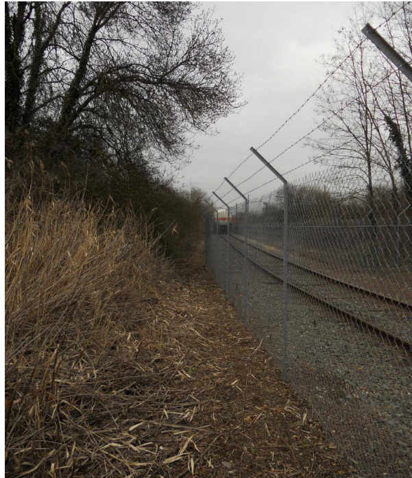
Figure 13 : Bordure du site Michelin à l'entrée de l'ITE dans le site, vue 12, source SYSTRA
