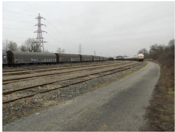
Figure 3 : Faisceaux de Sabarèges, vue en direction de l'est, vue 2, source SYSTRA
