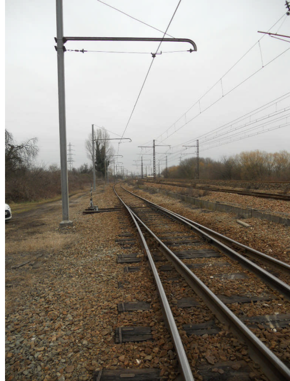
Figure 15 : Entrée de l'ITE Michelin, vue en direction du nord, vue 14, source SYSTRA
