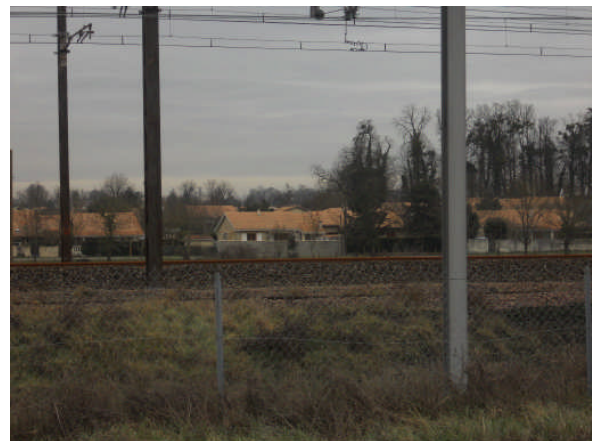
Figure 17 : Habitations du lieu-dit Sybille visible au niveau du bassin de rétention d'eau du site de Sabarèges, vue 16, source SYSTRA
