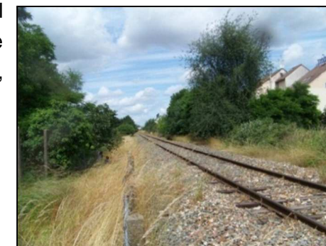
Figure 6- Ballaste et bas-côtés de la voie ferrée (source : ECE Environnement)
