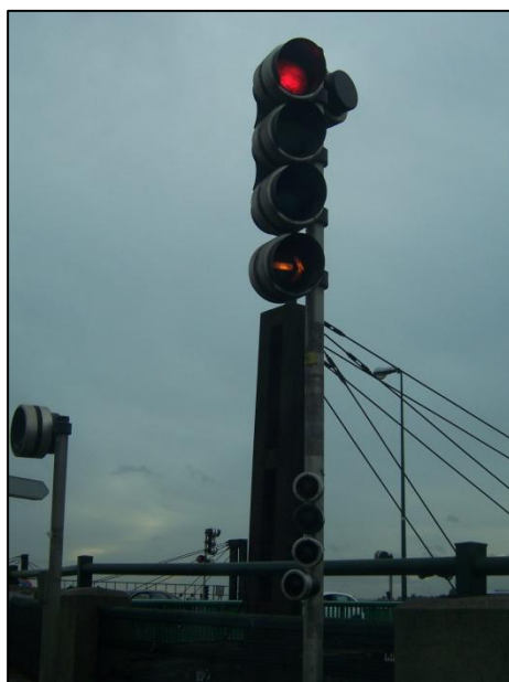
Flèche d'anticipation de tourne-à-droite de la RN6 Nord au carrefour de la tête de pont non accompagnée de voie dédiée au tourne-à-droite
