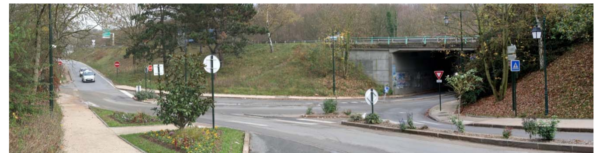
Photo 8 : L'entrée de ville de Bièvres, en venant de la RN306, le paysage est à connotation routière avec le passage supérieur de la RN118
