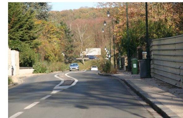
Photo 10 : La perception de la RN118 est forte et renforcée par la visibilité des véhicules qui l'empruntent
