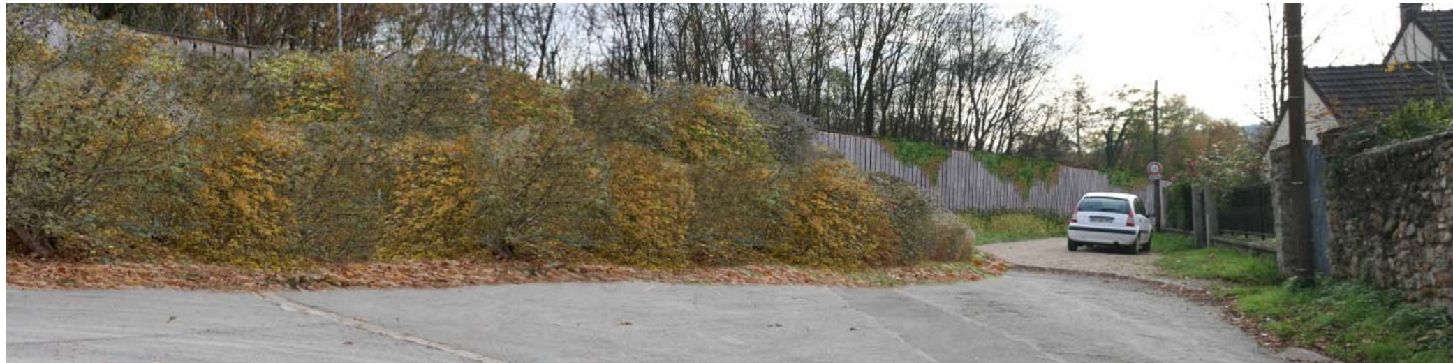
Photomontage 7 : La prolongation du merlon et sa végétalisation arbustive permet d'occulter la route et de conserver la forêt de Verrières en arrière plan
