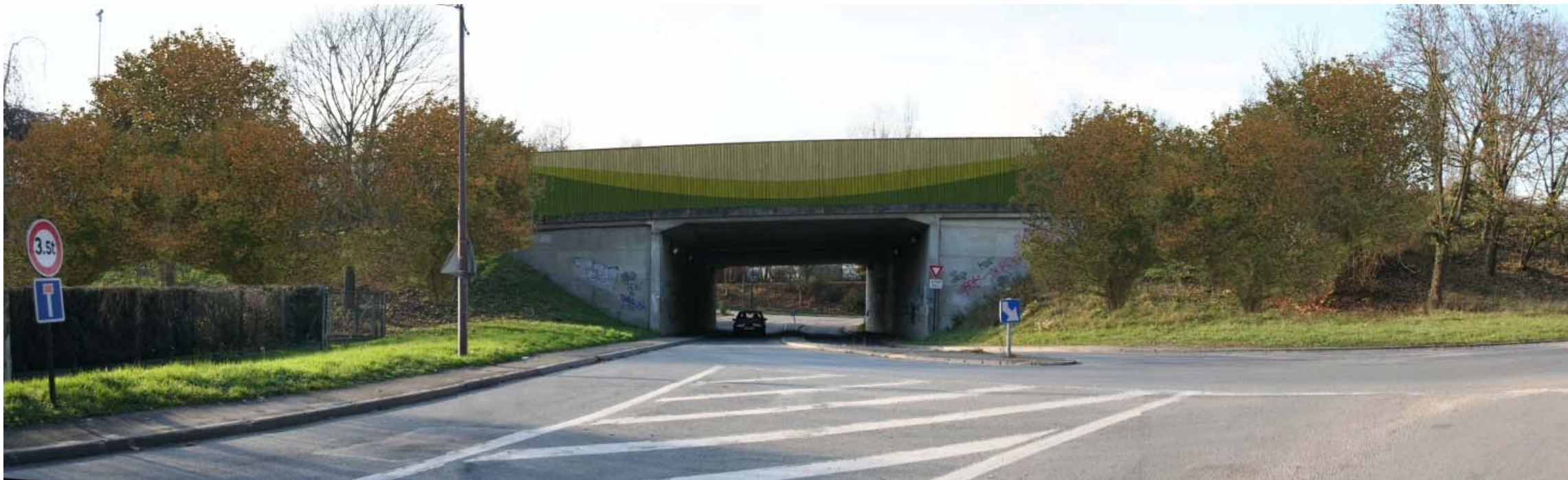
Photomontage 4 : La jonction entre l'écran de l'ouvrage d'art et celui implanté en pleine terre à gauche de la photo est accompagné par l'implantation de végétation arbustive ou des petits arbres de part et d'autre du passage former par le passage supérieur de la RN118
