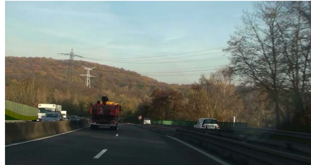
Photomontage 5 : Vision de la RN118 avec un écran sur ouvrage d'art, ici celui de la gare
