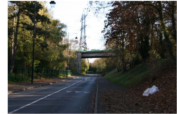
Photo 33 : avenue de la gare, le passage supérieur de la RN118 s'inscrit comme une porte d'entrée de ce secteur
