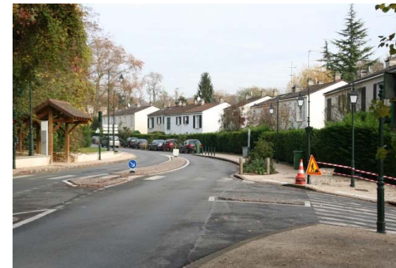
Photo 1 : la RD533, vue sur le bâti récent, la voirie marque une frontière entre le coteau boisé à gauche de la photo et le fond de vallée de la Sygrie à droite
