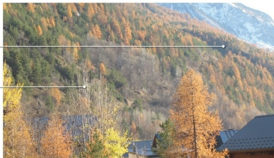
Simulation de la dépose de la ligne aérienne existante en vis-à-vis des habitations
