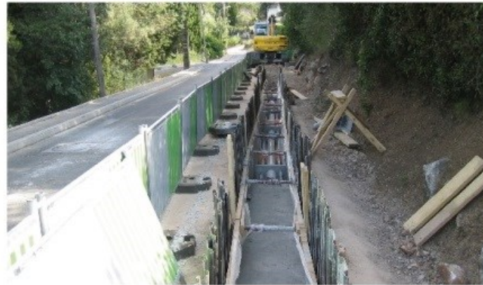
Tranchée ouverte sous chaussée
