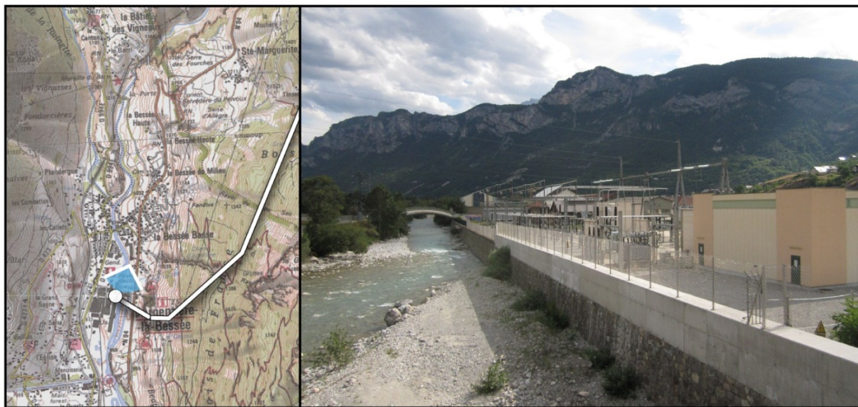
Poste électrique de l'Argentière
