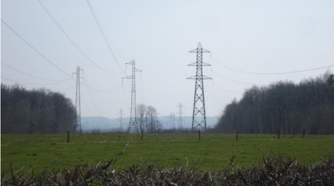
11/2013 : Support double ternes n°8, départ du tronçon de 1,7 km à construire, commune du Breuil.
