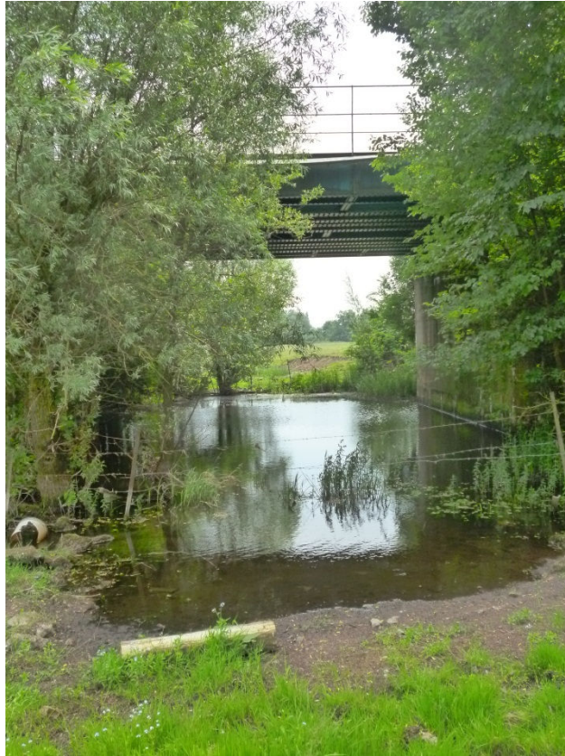
Photo 4 : Vue rapprochée de l'ouvrage du PK83+633 depuis le côté Nord.
