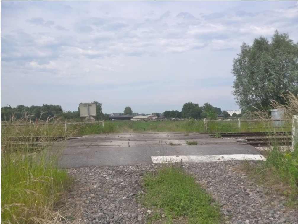
Photo 13 : Vue (en direction du Nord) du franchissement à niveau de la ligne Amiens-Laon par le chemin agricole.
