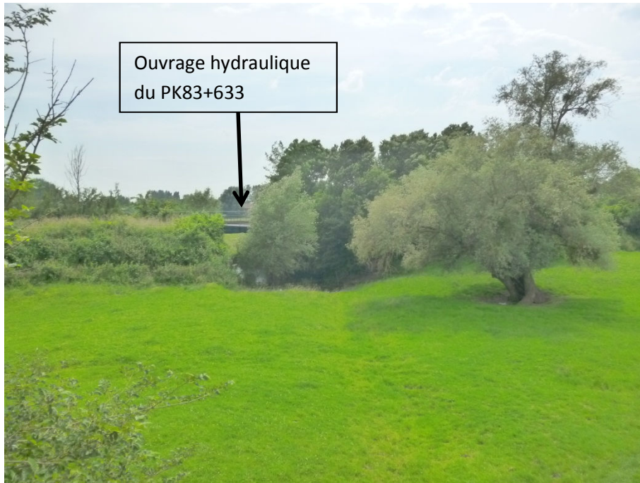
Photos 2 et 3 : Vues de l'ouvrage du PK83+633 depuis le remblai de l'ancienne voie ferrée côté Nord.
