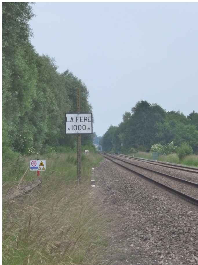
Photo 15 : Vue (en direction de l'Est) de la ligne ferroviaire Amiens-Laon depuis le remblai ferroviaire (au droit du franchissement par le chemin agricole).
