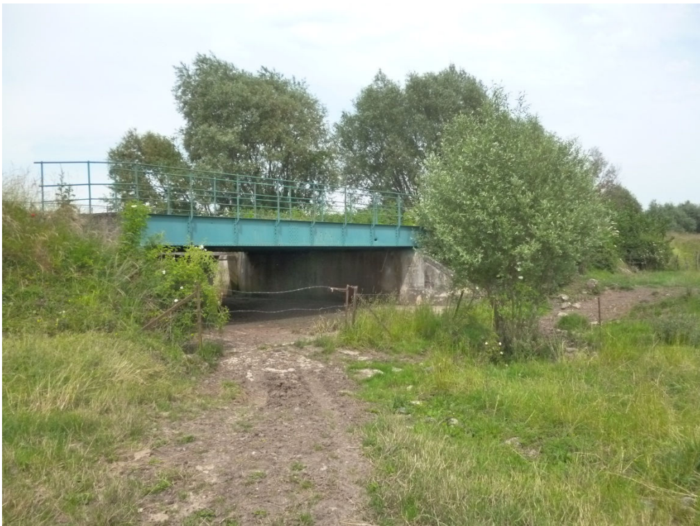
Photo 10 : Vue rapprochée de l'ouvrage du PK84+033 depuis les pâtures côté Sud.
