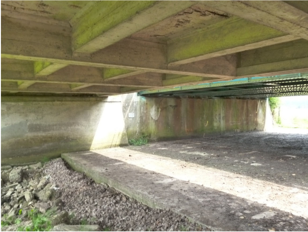
Photo 9 : Vue sous l'ouvrage du PK84+033.
