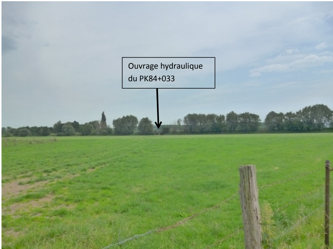
Photo 6 : Vue depuis le chemin agricole côté Nord de la voie ferrée en direction de l'ouvrage du PK84+033.
